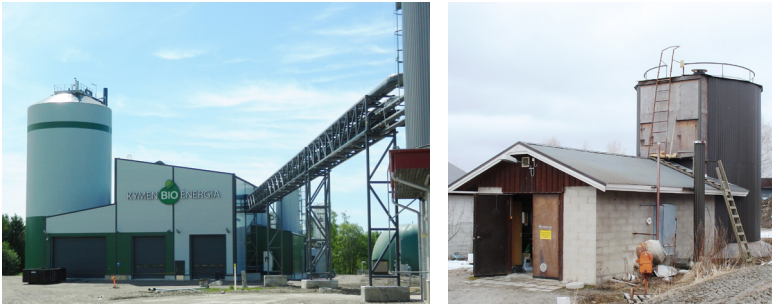
Kuva 10.1 Kouvolan jätevedenpuhdistamolla ja Kalmarin maatilalla sijaitsevat biokaasulaitokset ovat esimerkkejä laitoksista, jotka yhteismädättävät monenlaista biojätettä ja tuottavat niistä sekä lannoitteita, sähköä, lämpöä että liikennepolttoainetta. Kuvat: Ari Lampinen
