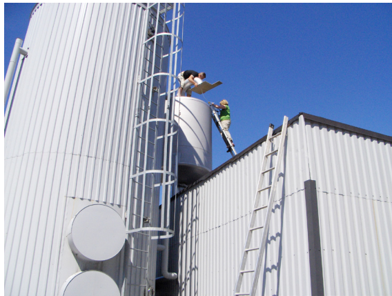
Kuva 8.2 Etualalla vasemmalla hajukaasupesuri, oikealla suljettu biosuodatin ja keskellä aktiivihiihisuodatin. Hajukaasunäytteenotto aktiivihiihisuodatuksen jälkeen käynnissä. Biovakka Suomi Oy, Vehmaan biokaasulaitos. Kuva: Teija Paavola
