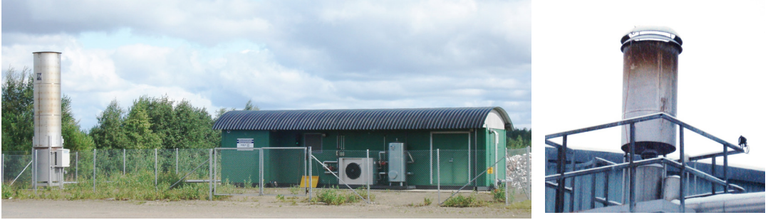
Kuva 7.2 Soihuja Joensuun kaatopaikalla (a) ja jätevedenpuhdistamolla (b). Kuvat: Ari Lampinen
