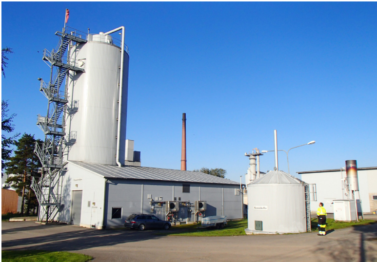
Kuva 1.5 Apetit Suomen hallinnoima Länsi-Säkylän teollisuusalueen prosessi- ja jätevesiä käsittelevä IC-reaktorilaitos. Kuva: Watrec Oy.
