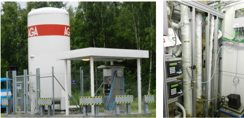
Kuva 7.21 Biokaasun sisältämän hiilidioksidin kehittyneitä hyödyntämistapoja: a) Kylmäkuljetusautojen \text{LCO}_2 -tankkauspaikka Lidköpingissä Ruotsissa. Biokaasulaitos, joka tuottaa LBG:tä ja \text{LCO}_2 :tä, sijaitsee puolen kilometrin päässä. b) Biokaasulaitoksen hiilidioksidia tuulimetaanin valmistuksessa hyödyntävä Sabatier-reaktori Fraunhofer-instituutissa Bad Hersfeldissa. Kuvat Ari Lampinen
