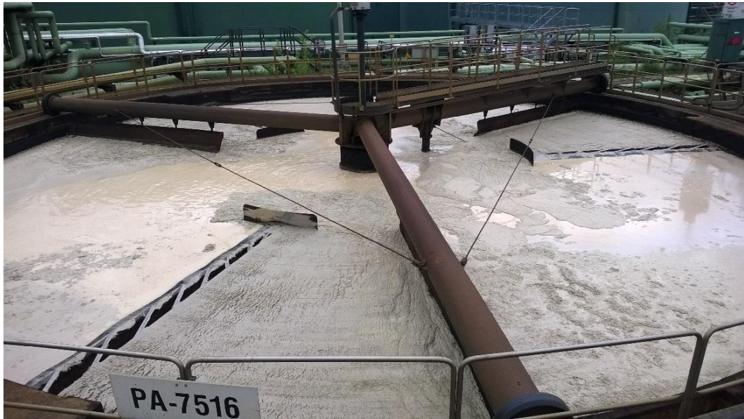
Kuva 3. Nesteen jätevesilaitoksen flotaattori 18.6.2014. Rasva muodosti savimaista kakkua flotaattorin pinnalle tukkien lopulta pintalietekourut kokonaan.
