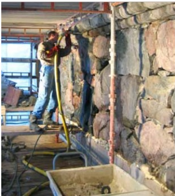
Kuva 80. Laastin pumppausta muurin aukkoihin Suomenlinnassa. [21 s. 98]
