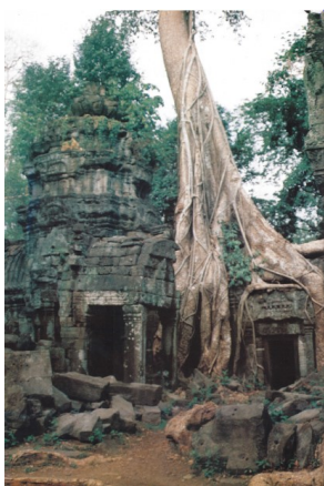
Kuva 17. Myös kasvillisuus vaurioittaa muureja. [31 s.10]
