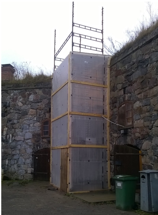
Kuva 37. Laastityöt vaativat talvella sääsuojauksen ja lämmityksen.
