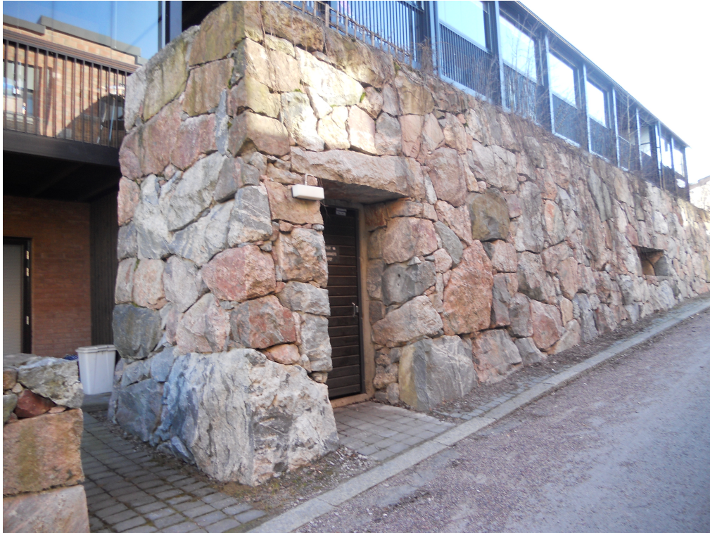
Kuva 13. Uutta paikalla louhitusta kivistä rakennettua verkkomuuria Viikissä. [3]
