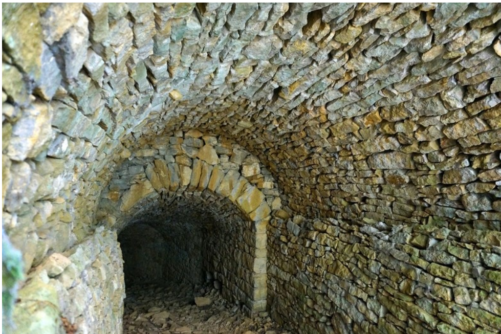
Kuva 67. Kylmä-holvitunneli, Saint-Romain-au-Mont-d'Or Ranskassa 1800-luvulta. [38]
