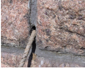
Kuva 22. Laastisaumojen kuntoa voidaan tarkastaa esim. harjateräksellä tötkkimällä. [43]
