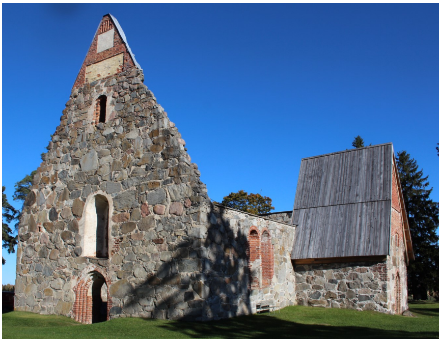
Kuva 86. Pälkäneen Pyhän Mikaelin kirkko ilman vesikatetta. [kuva shl.fi]
