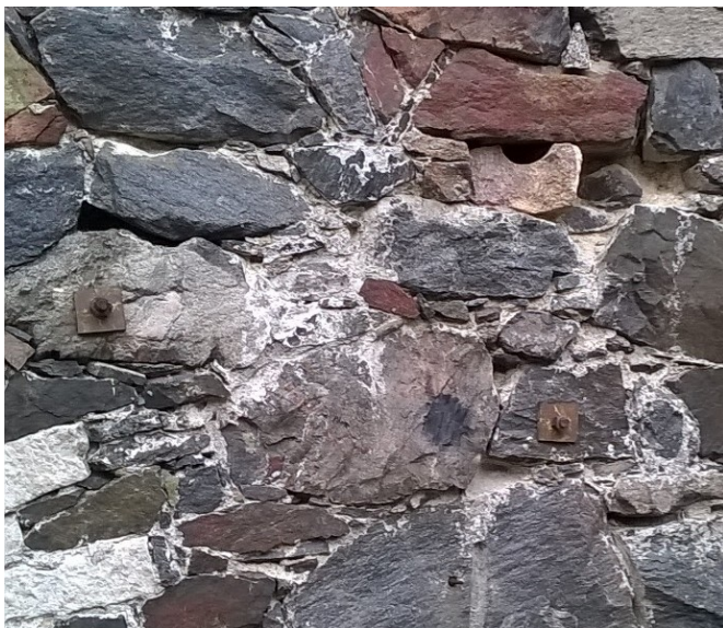
Kuva 83. Pulttaamalla vahvistettua muuria Suomenlinnassa.
