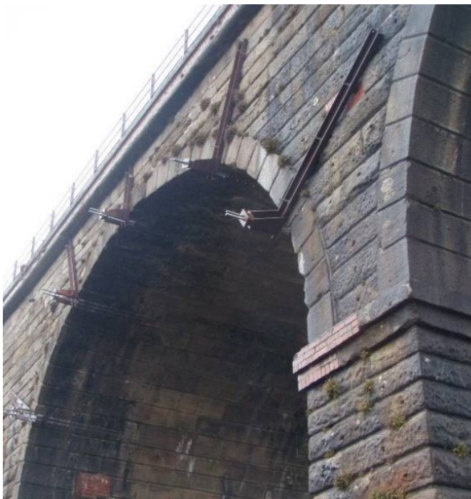
Kuva 84. Siltakaaren tuenta teräskiskoilla [35 s.16]
