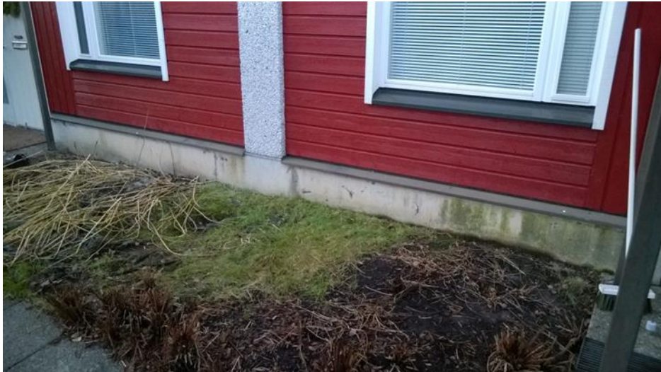
Kuva 3. Istutuspenkit kiinni perusmuurissa.
