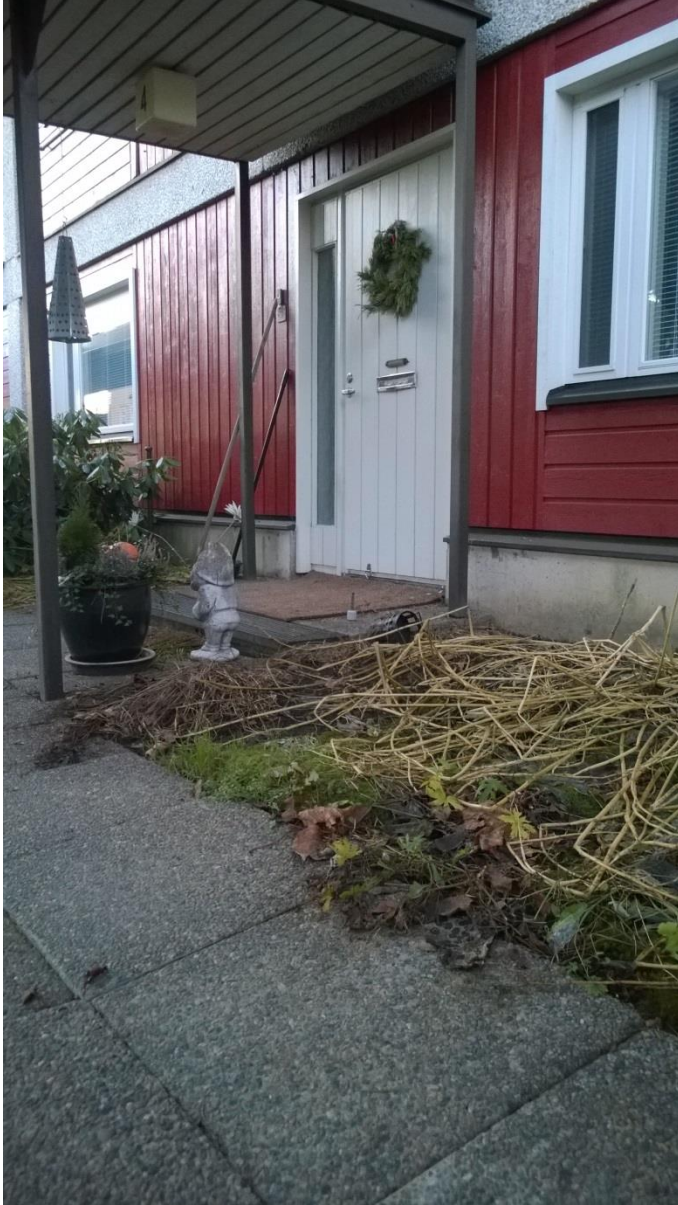
Kuva 11. Ulko-oven kynnys perustusten yläreunan alapuolella.
