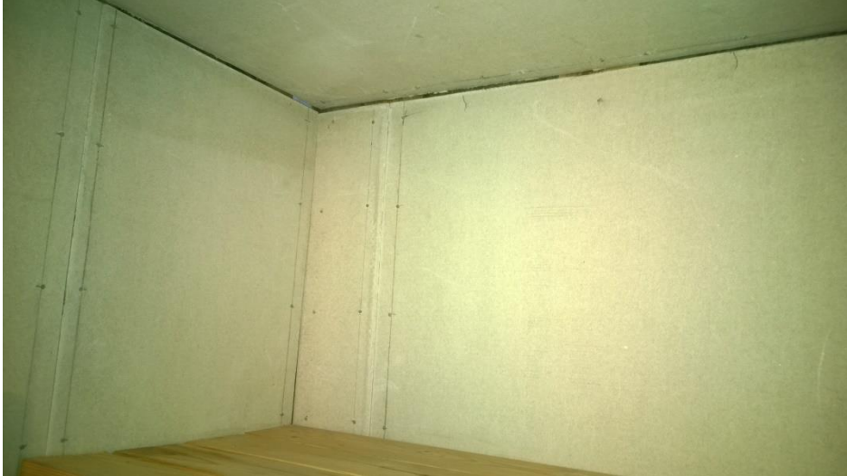
Kuva 29. Talouskellarin seinien ja katon liittymä.
