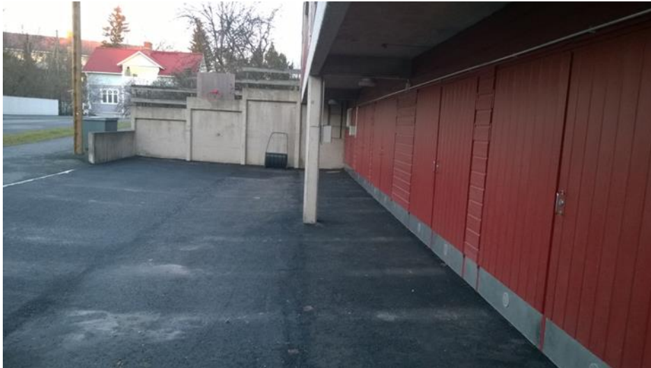
Kuva 2. Uusittu asfaltointi autotallien edustalla, toimii myös leikkialueena.
