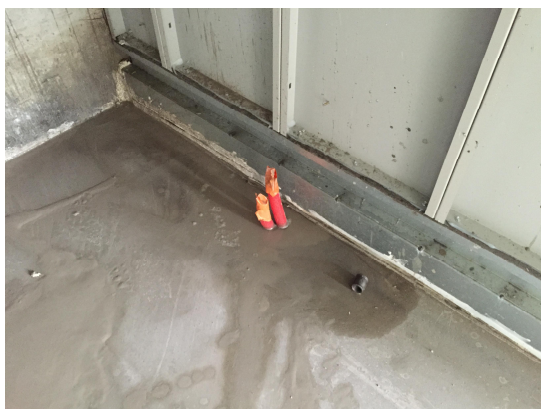
Kuva 12. Tarkastusputket, jotka ulottuvat kylpyhuone-elementin alle kuvausta ja kuivatusta varten. (6)
