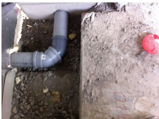
Kuva 11. Viemäri liitetty nousuputkistoelementtiin.(6)
