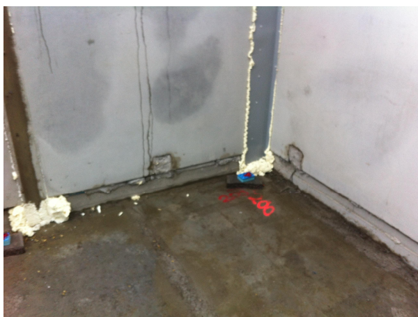
Kuva 2. Seinäelementtien pystysaumausta varten asennetut peltiliuskat.(6)
