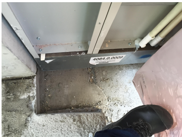
Kuva 8. 20mm asennusväli kantavan seinän ja kylpyhuone-elementin välissä. (6)
