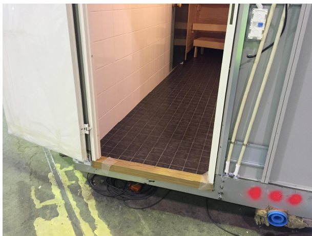
Kuva 5. Kylpyhuone-elementin alla kulkeva viemäri. (6)
