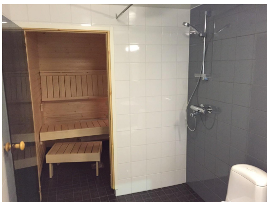
Kuva 1. Kylpyhuone-elementti tehtaalla valmiiksi kalustettuna. (6)
