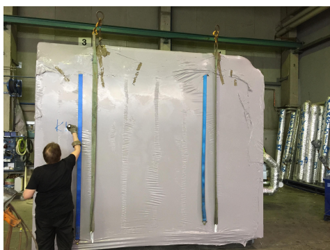
Kuva 7. Kylpyhuone-elementti tehtaalla suojattuna. (6)
