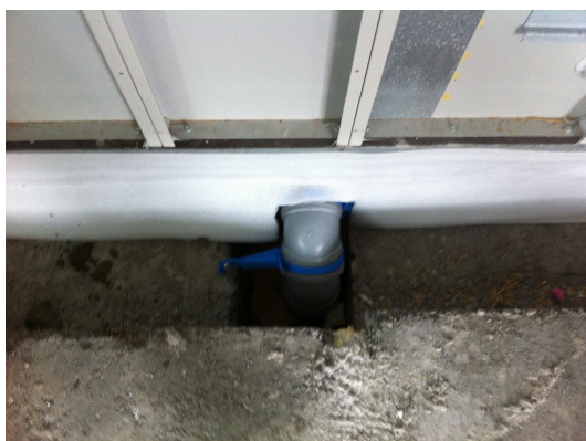
Kuva 10. Viemäri liitetty alapohjassa kulkevaan viemäri linjaan. (6)
