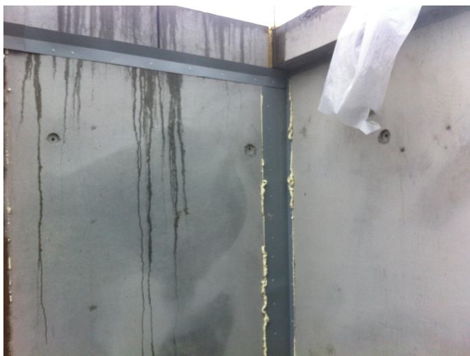
Kuva 3. Peltiliuskat ontelosaumavalua varten asennettuina. (6)
