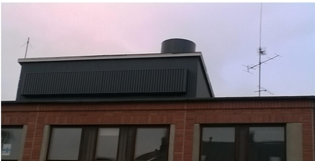
Kuva 12. Jussinkylän päiväkodin vesikatolle rakennettu uusi iv-konehuone.
