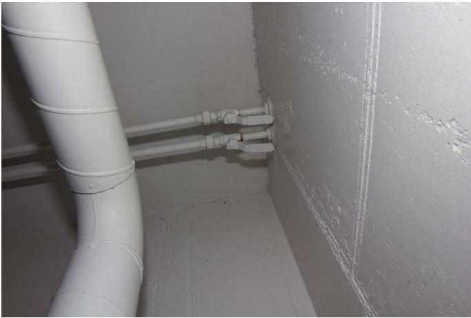
KUVA 37. Yläkoulun putkien läpivienti
