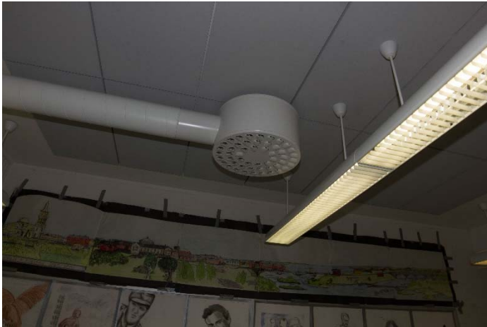
KUVA 4. Uusittu luokkatilan päätelaite.
