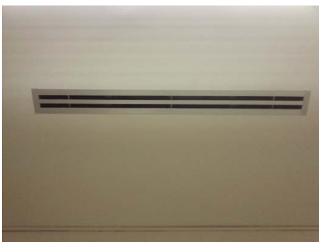
KUVA 46. Tuloilmapäätelaite
