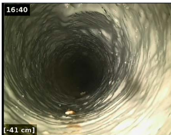
KUVA 14. Korjattu putki massauksen jälkeen
