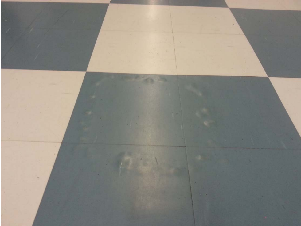
KUVA 10. Lattiapinnoite vedetty puhdistusyhteen yli.
