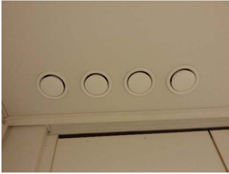
KUVA 47. Poistoilmapäätelaite
