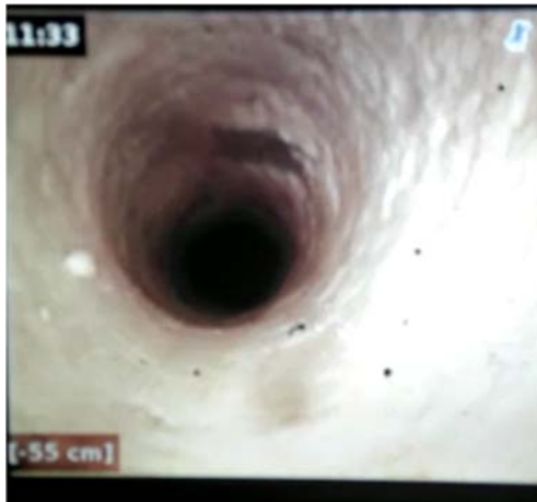
KUVA 13. Halkeaman kohdalle tehty paikkaus muotituksella.
