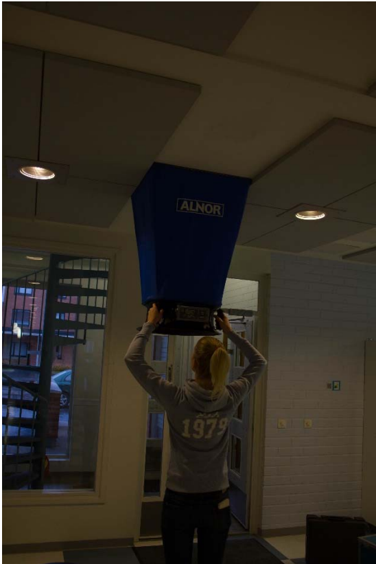
KUVA 9. Ilmavirran mittaus balometrillä.
