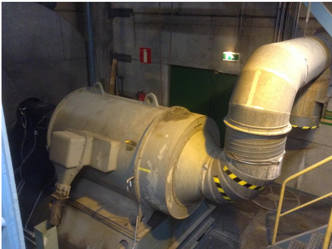
Kuva 8, Palamisilmapuhaltimen vanha moottori
