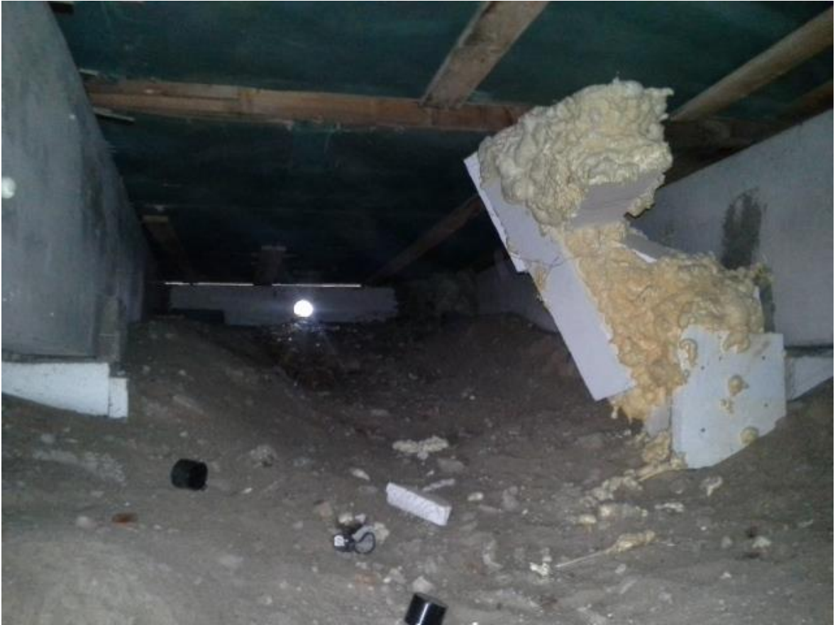
Kuva 5 Tuulettuva alapohja, tuuletusaukko
