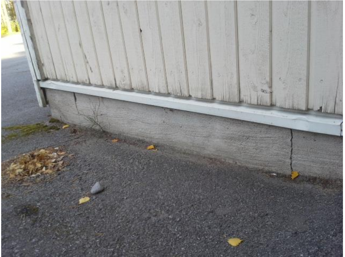
Kuva 4 Sokkelin halkeamia
