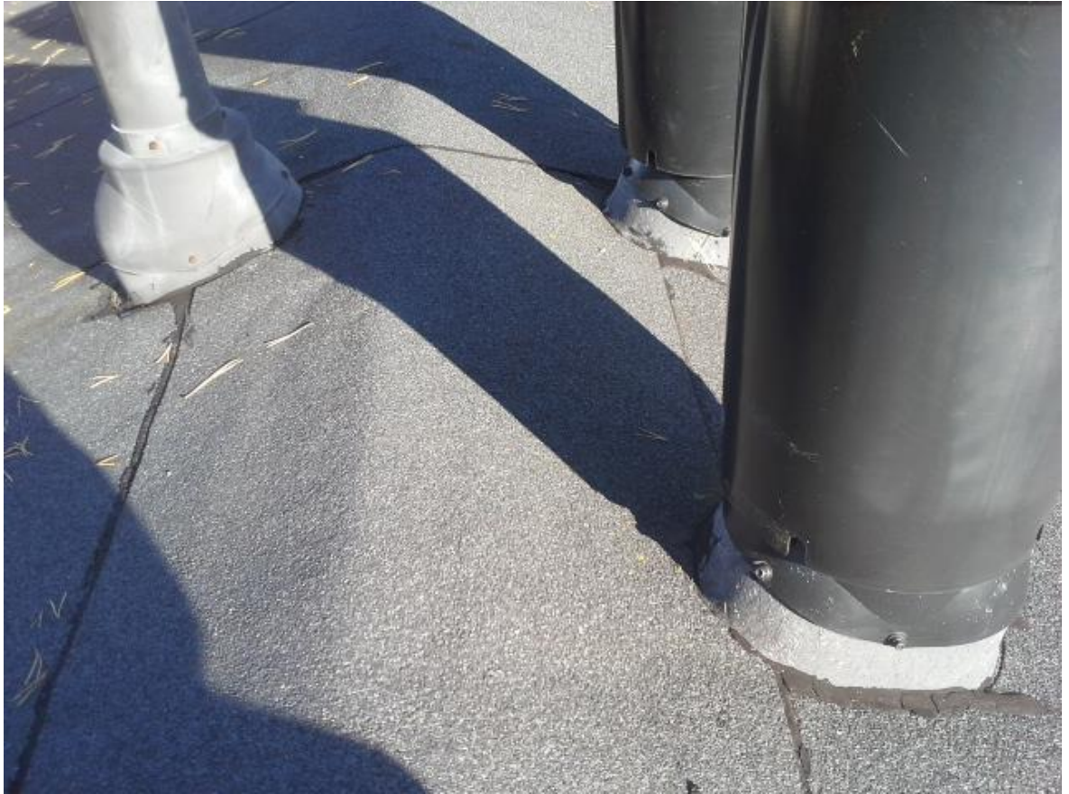
Kuva 9 Läpivientien tiivistys
