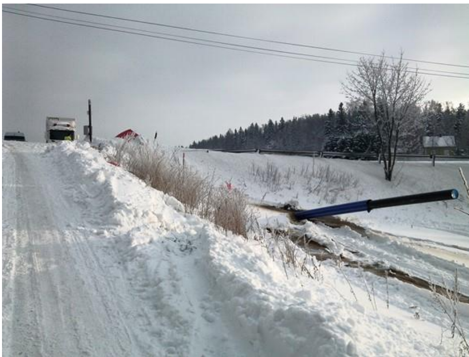
Kuva 4. Tienalitus suuntaporaamalla.(Kuva: Juho Hanni, 2012)
