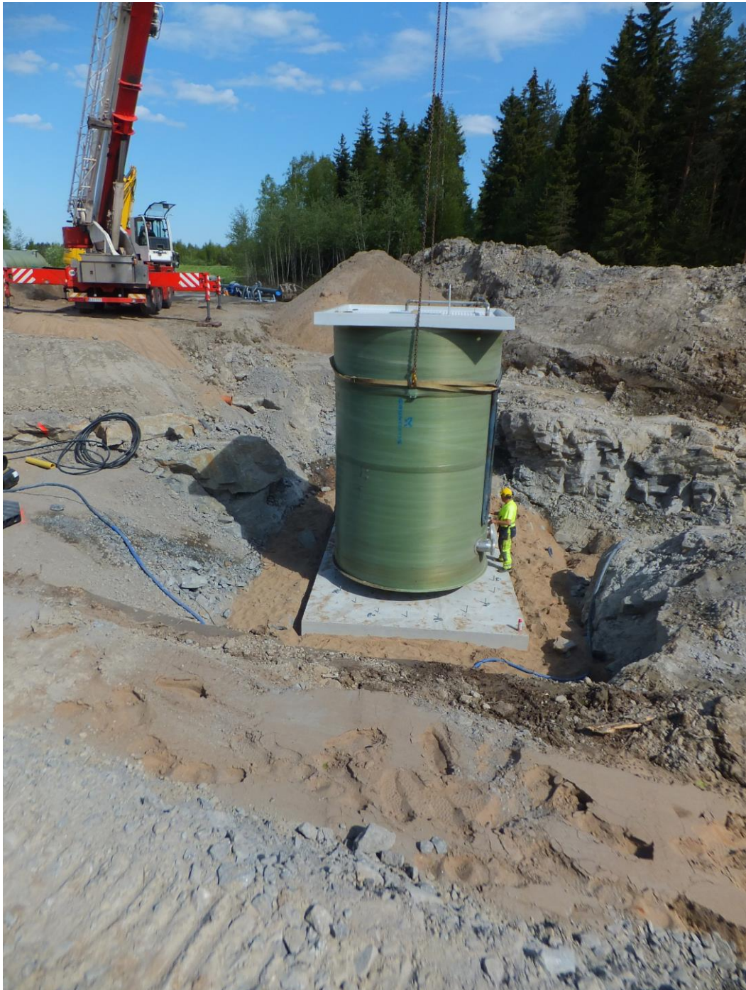
Kuva 3. Tukematon pumppaamokaivanto. (Kuva: Kokkolan Vesi)
