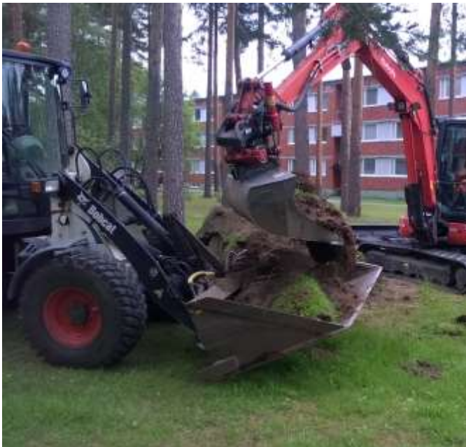
Kuva 10. Kaivumaan poiskuljetusta talon eteläpuolelta
