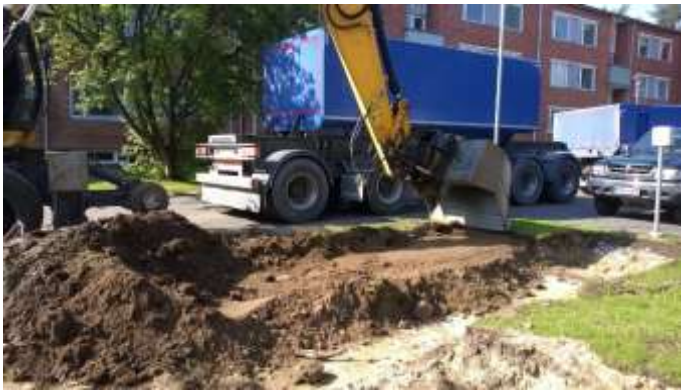
Kuva 7. Laaja piha-alue mahdollisti suurten koneiden käytön saneerauksen eri vaiheissa.
