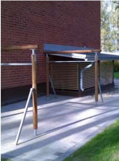
Kuva 24. Kuivausteline asennettuna kiveyksen alle
