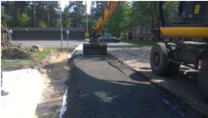
Kuva 15. Kantavan kerroksen levitys ja tasaus
