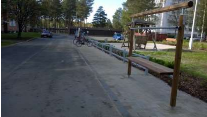
Kuva 26. Pyörätelineet, tuuletusteline ja roska-astia paikoilleen valettuna
