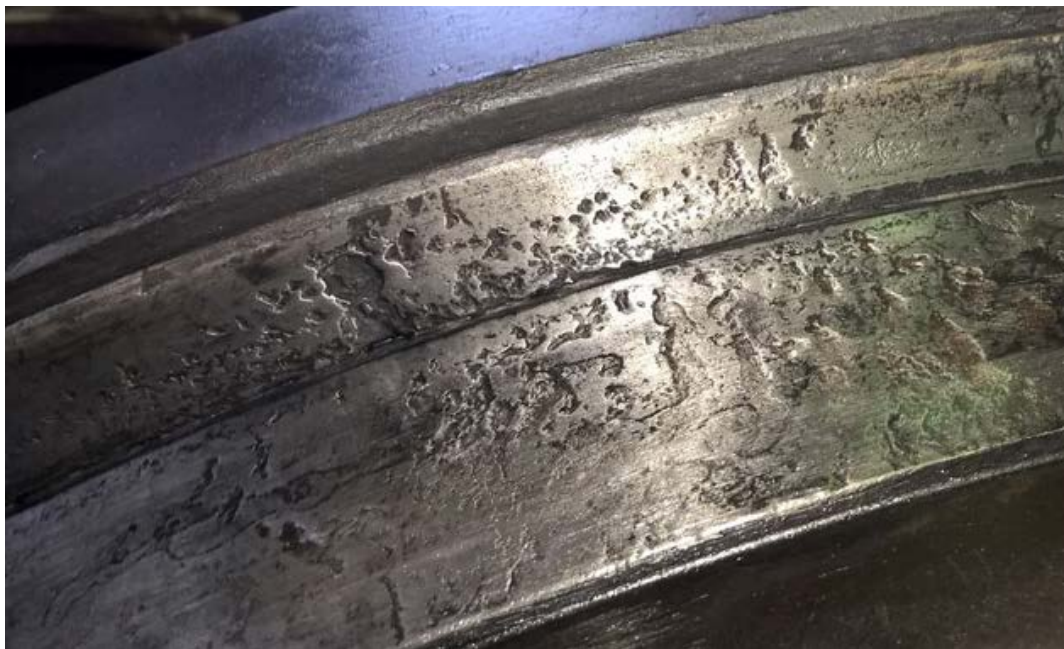
Kuvio 28. Eroosio - korroosiota tiivistepinnalla
