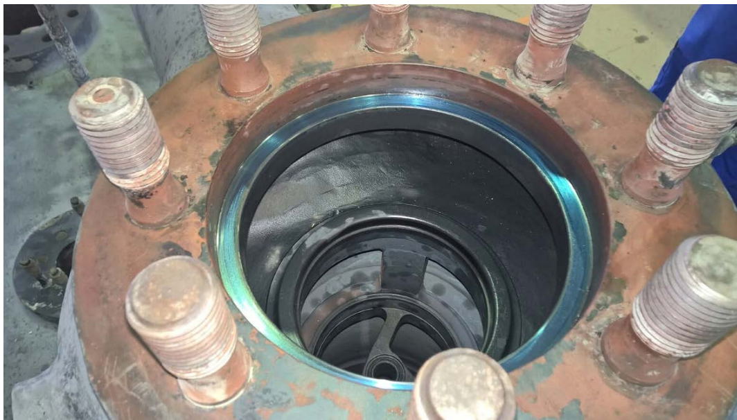
Kuvio 27. Venttiilirungon tiiveystarkastus
