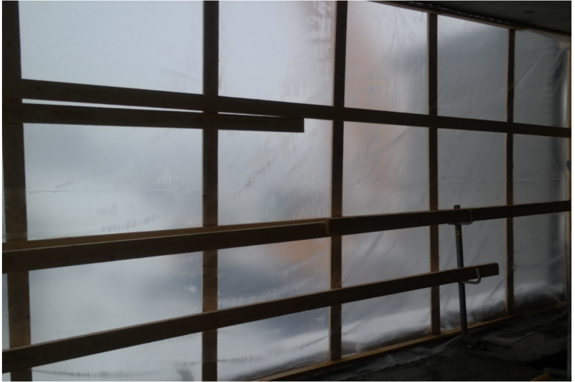
KUVA 5. Väliaikaiset seinät estävät lämmön karkaamisen (Hartikainen 2016-01-26)
