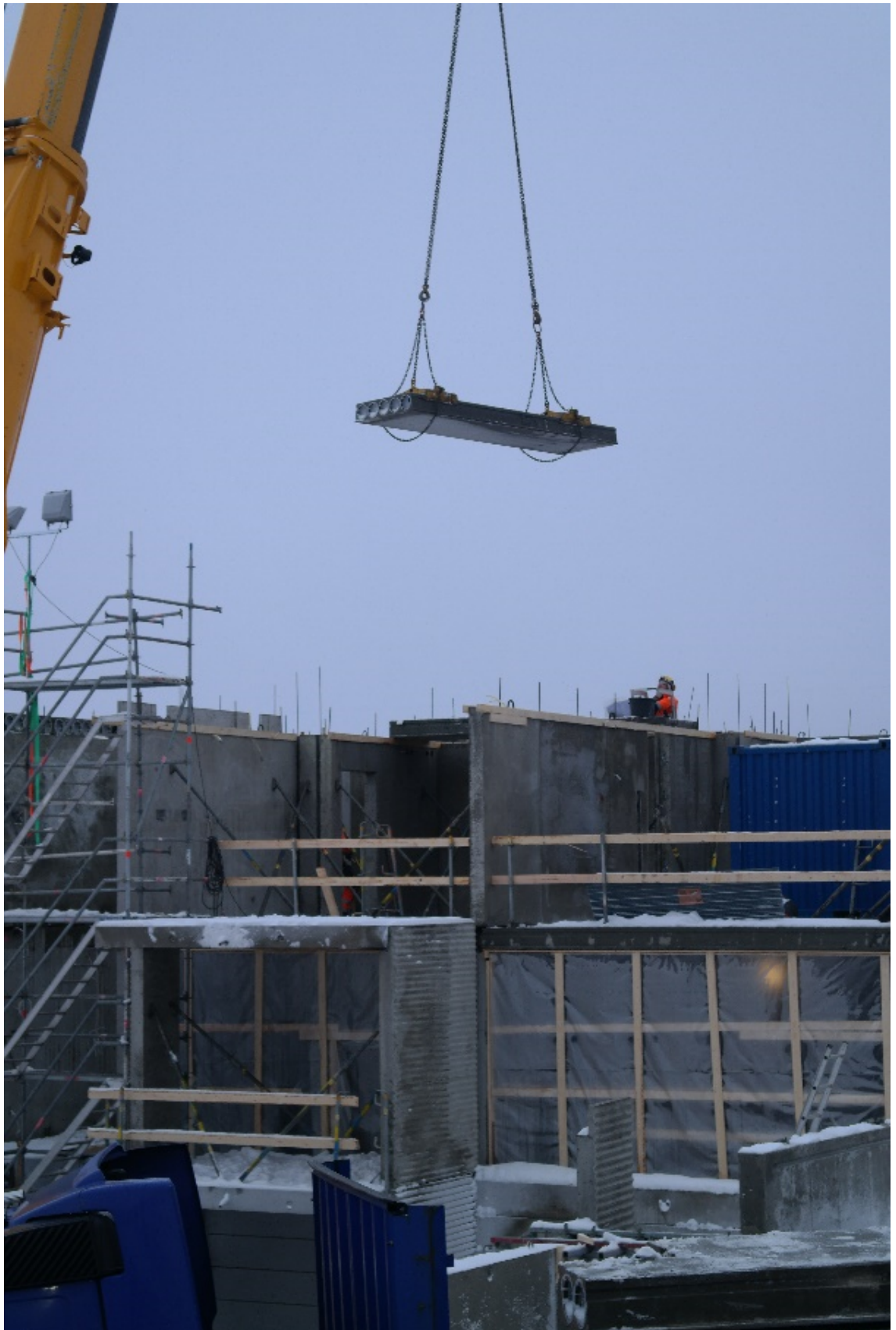
KUVA 3. Ontelolaatta asennetaan käyttäen nostosaksia (Hartikainen 2016-01-27)
