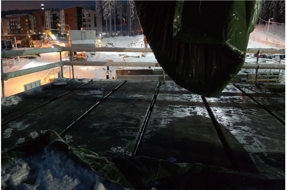
KUVA 8. Ontelolaatan pinta puhdistuu lumesta kun suojapeitteet siirretään pois, myös pinta on ilmaa lämpimämpi (Hartikainen 2016-01-29)
