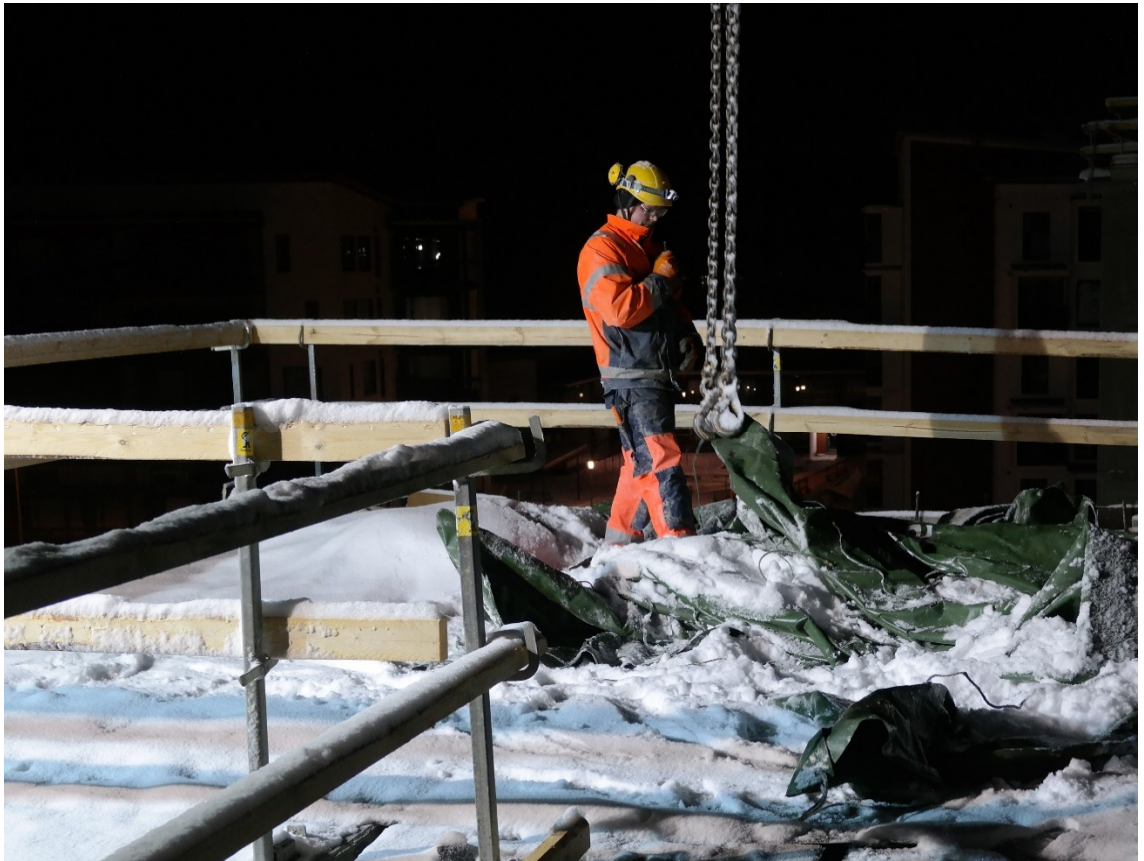
KUVA 7. Ontelolaattojen päälle asennettu suojapeite suojaa lumelta ja lämmön karkaamiselta (Hartikainen 2016-01-29)
