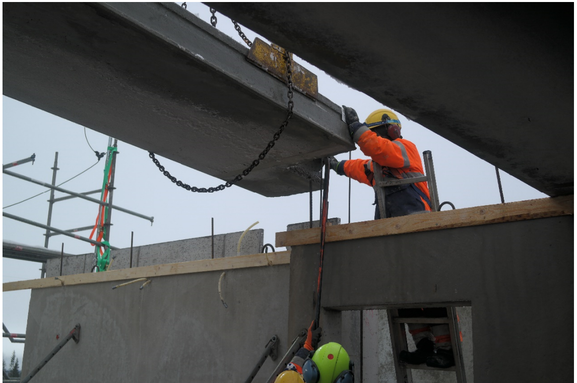
KUVA 4. Ontelolaatta ohjataan paikalleen käyttäen kankea (Hartikainen 2016-01-27)
