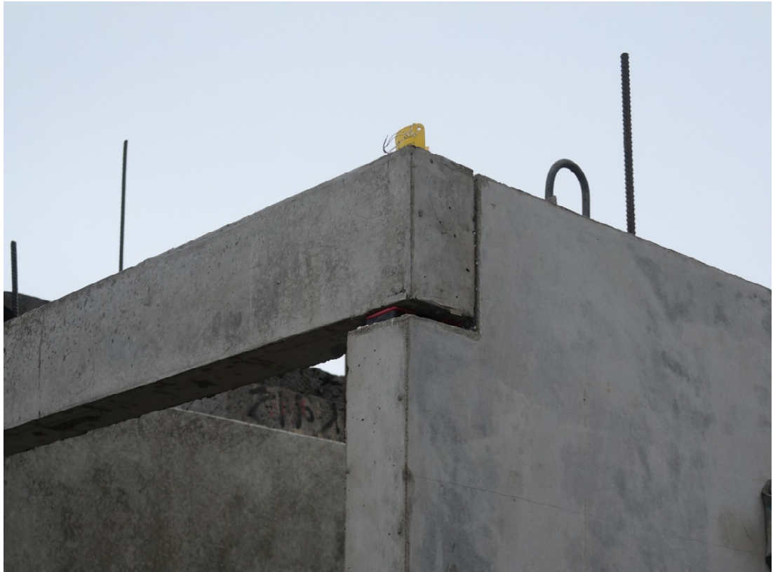
KUVA 10. Elementtien alle asennettavat asennuspalat, joilla elementti saadaan oikeaan korkoon. (Hartikainen 2016-01-27)
