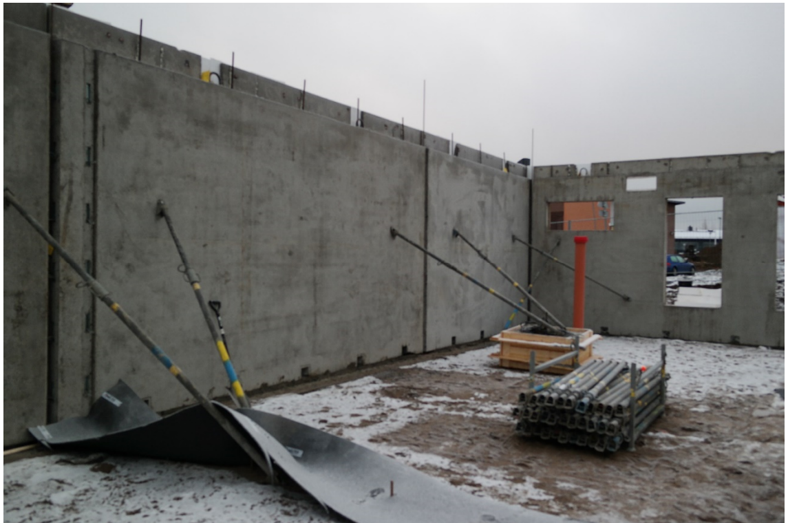
KUVA 11. Seinäelementtien tukeminen ja anturoiden suojaus elementtien kiinnitystä varten (Hartikainen 2015-12-04)
