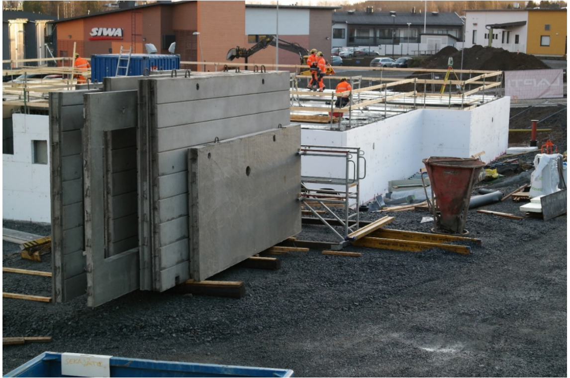
KUVA 9. Elementtien välivarastointi karnatelineisiin (Hartikainen 2015-12-11)
