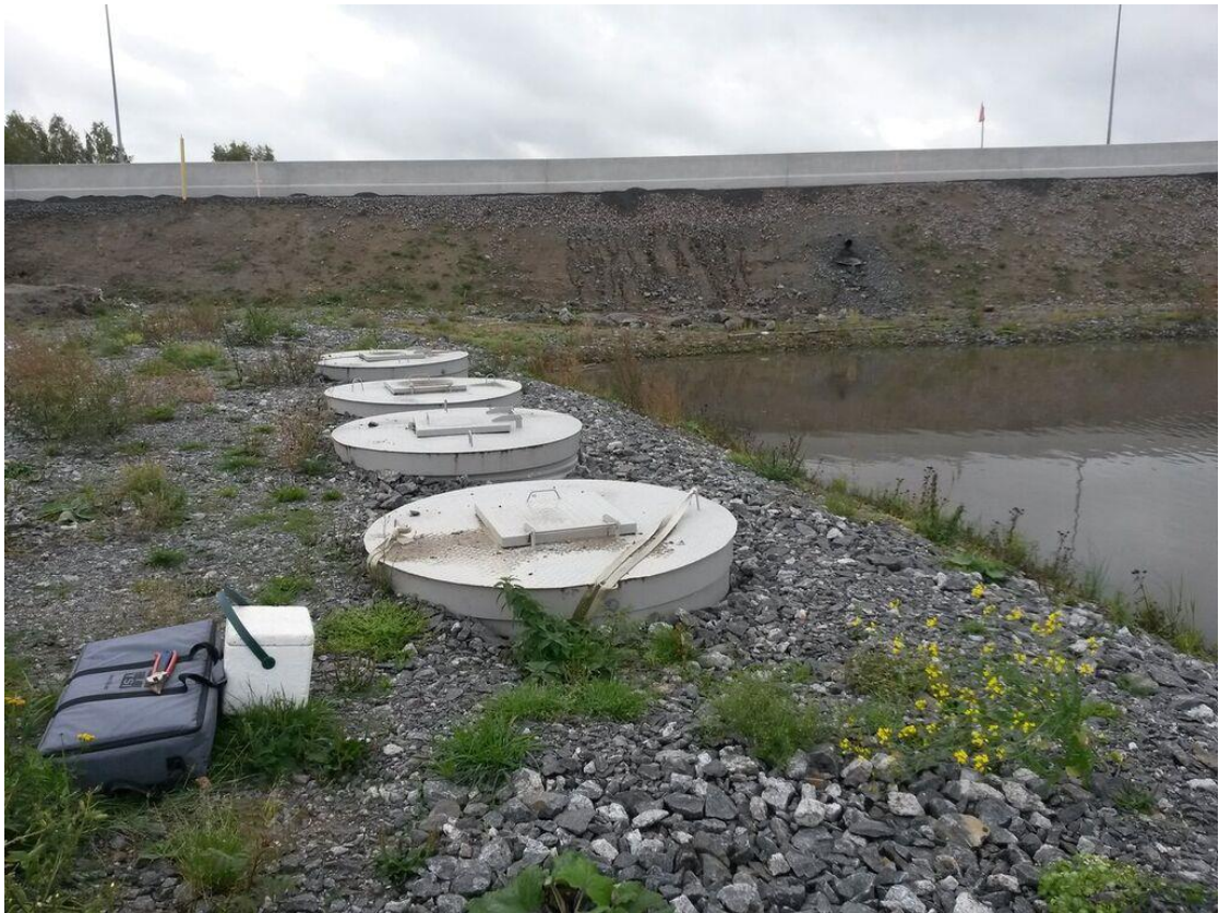
KUVA 9. Työmaa-alueella sijaitsevat munkkipadot (Viljanen 2015)
