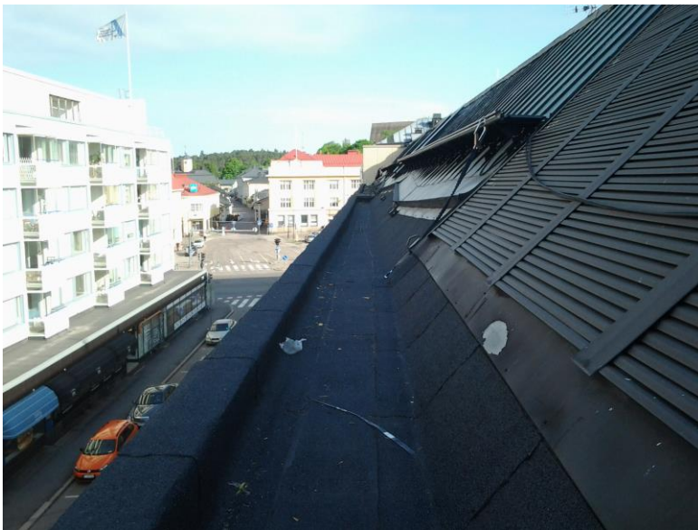
Kuva 18. Bitumikaton reuna ennen pellinasennusta
