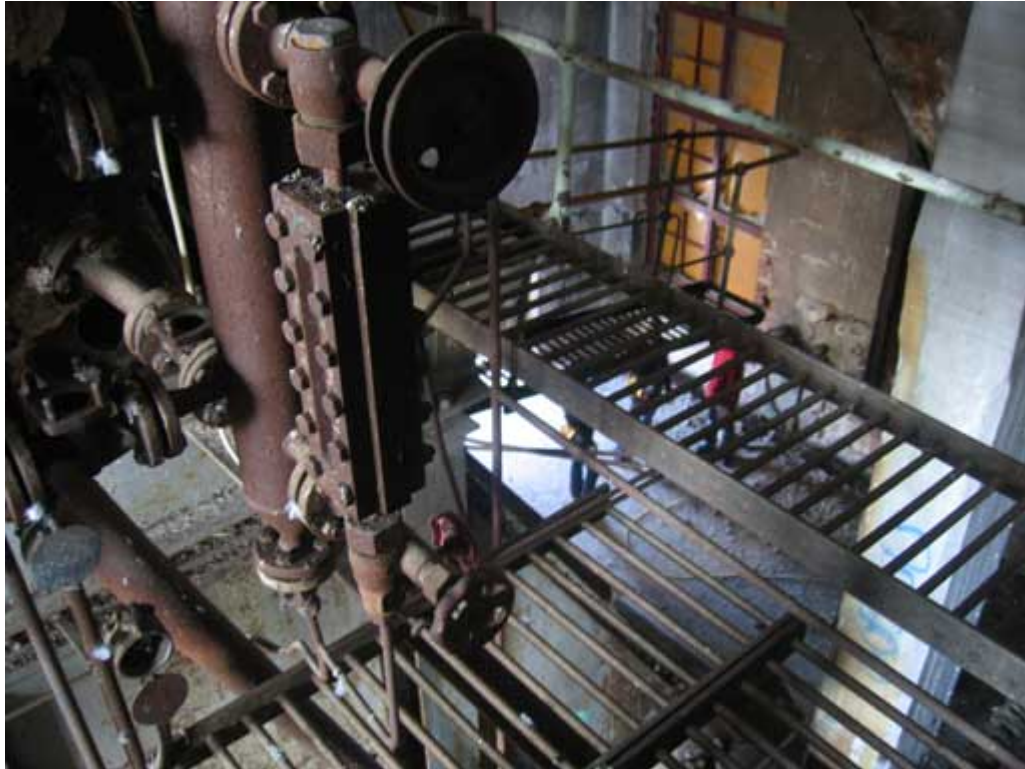
Kuva 9: Tehdastila oli kolmen kerroksen korkuinen. Kuva: Ilmari Huttu-Hiltunen
