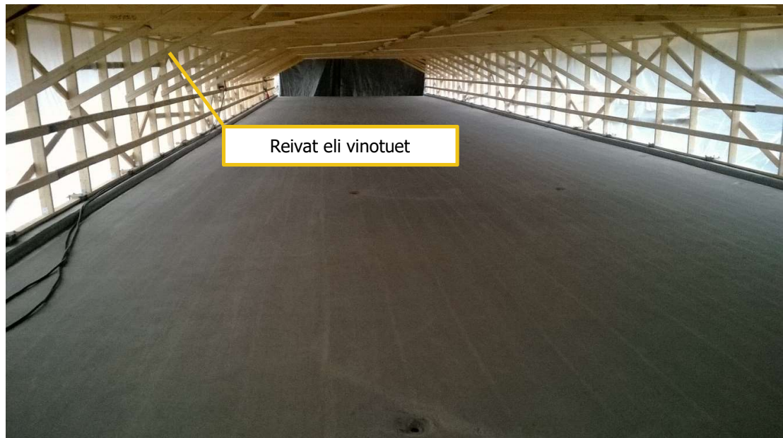
KUVA 6. Ristikkopalkeista rakennettu sääsuoja sisältäpäin katsottuna. (Taskinen 2015-09-16)
