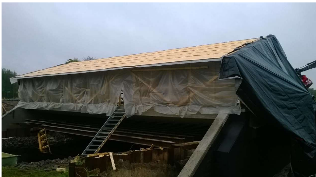
KUVA 3. Kattoristikoista rakennettu sääsuoja ulkoapäin. (Taskinen 2015-09-16)
