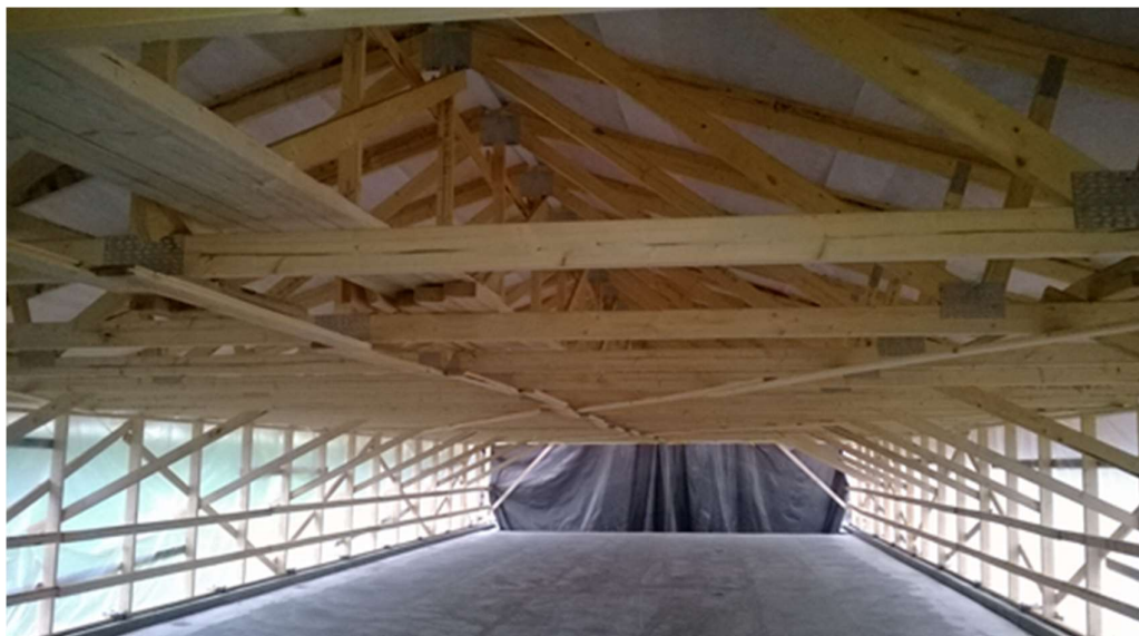
KUVA 2. Kattoristikoista rakennettu sääsuoja sisältäpäin. (Taskinen 2015-09-16)
