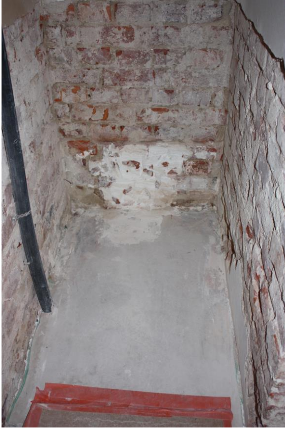
Kuva 6. Olohuoneen vaatehuoneen syvennys. Lattiasta poistettu parketti. Seinistä poistettu maali ja tasoite.
