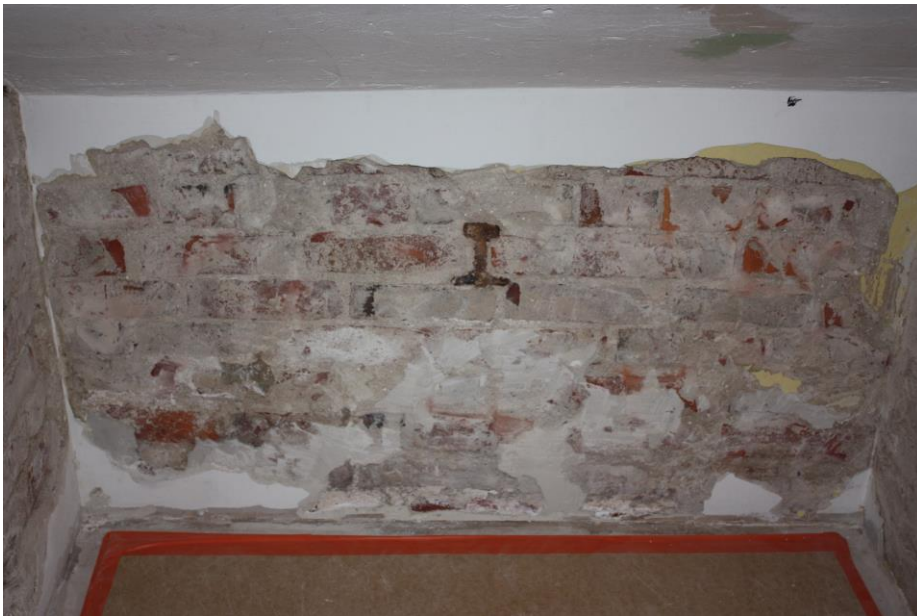
Kuva 7. Olohuoneen perällä olevan varaston seinistä poistettu maali ja tasoitteet. Lattiat suojattu.
