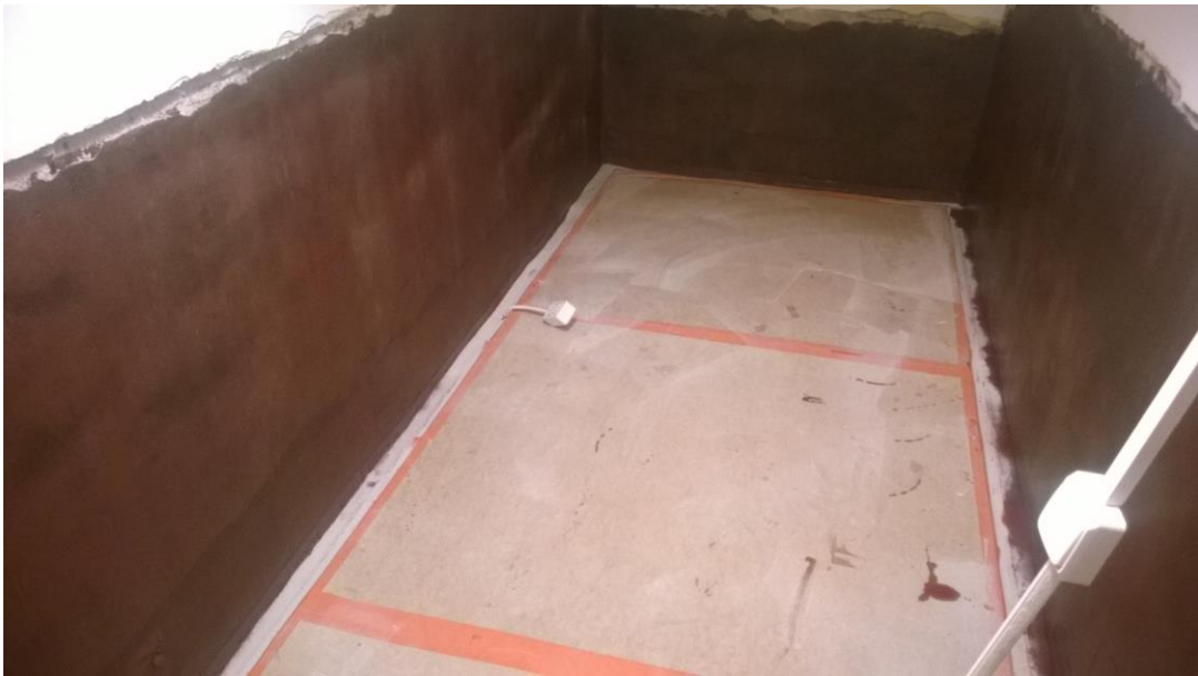
Kuva 9. Epoksinnoite laitettu seiniin ja lattia suojattu.
