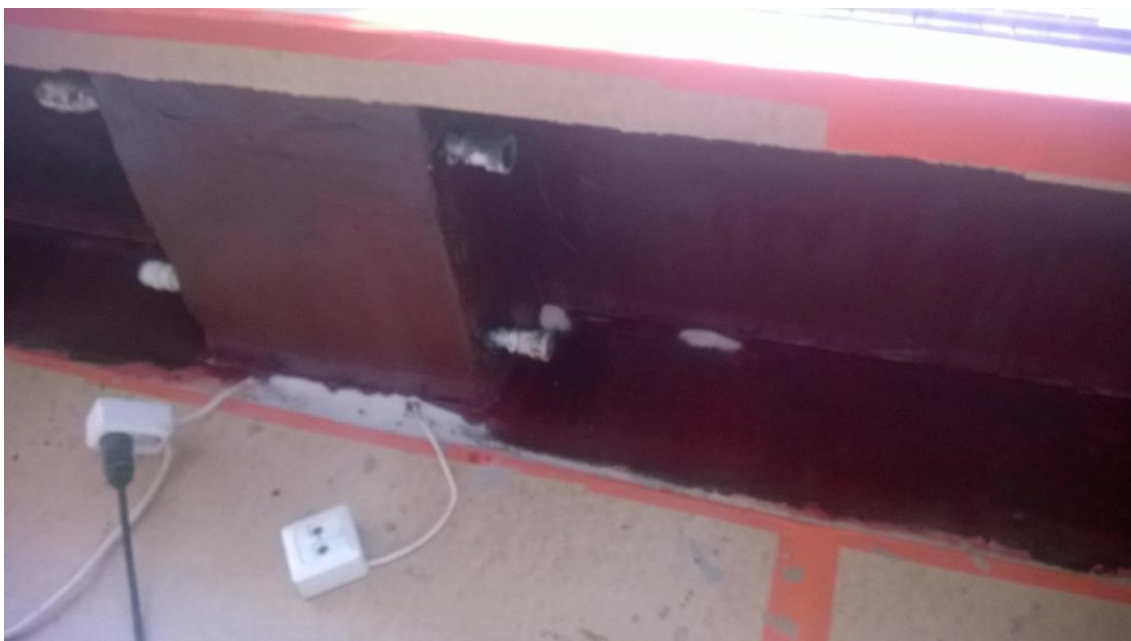
Kuva 10. Epoksinnoite laitettu patterisyvennyksiin.
