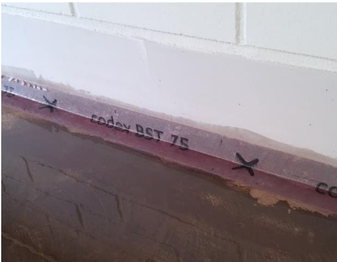
Kuva 21. Lattian ja seinän rajakohdan tiivistys
