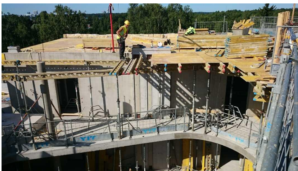
KUVA 3. Muottityöt käynnissä (Kytölä 2015-07-08)
