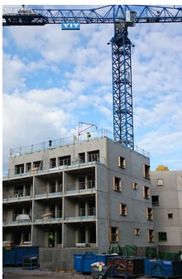
KUVA 2. Rakennuksen runko (Kytölä 2015-07-21)
