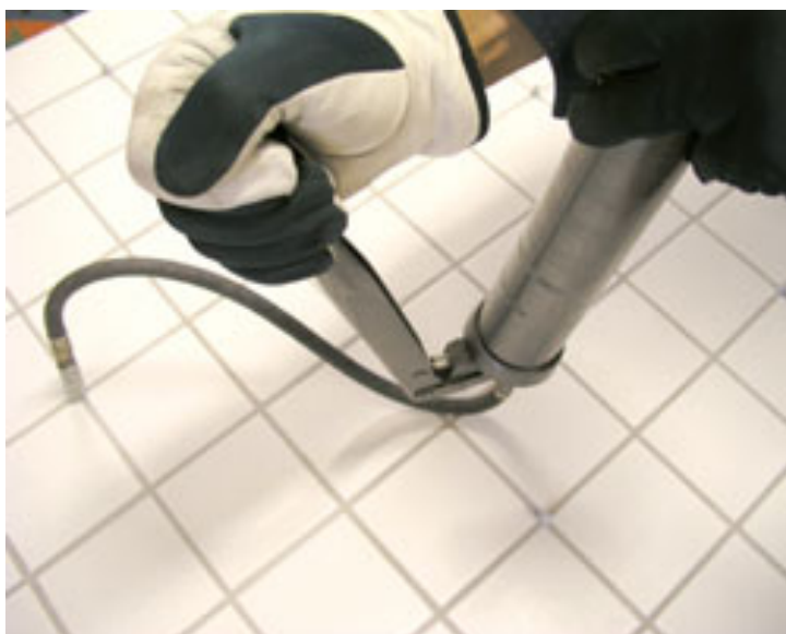
Kuva 9. Irronneen laatan kiinnitys injektoimalla (17)
