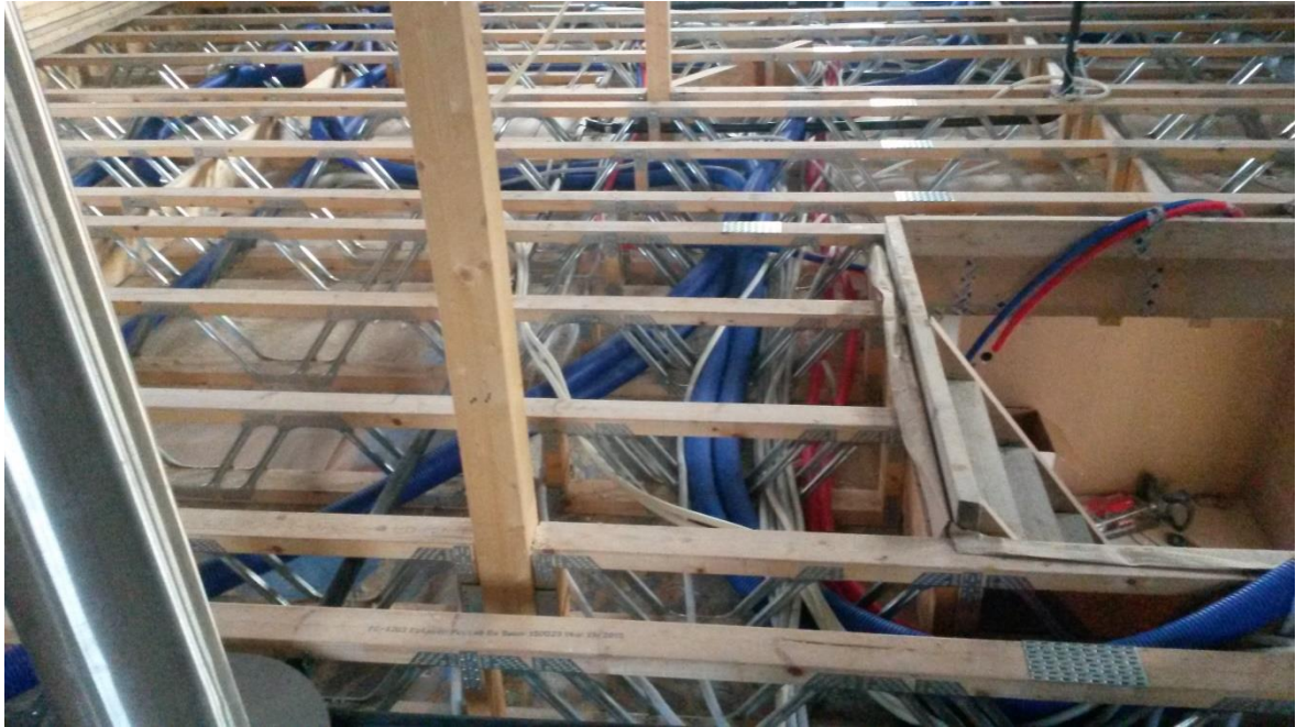
Kuva 5. 1,5-kerroksisen talon välipohjarakenne.
