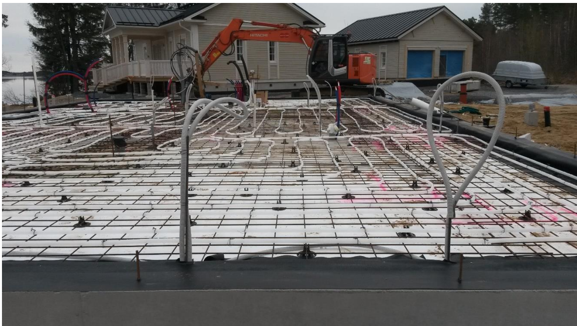
Kuva 2. Alapohja ennen laatan valua.
