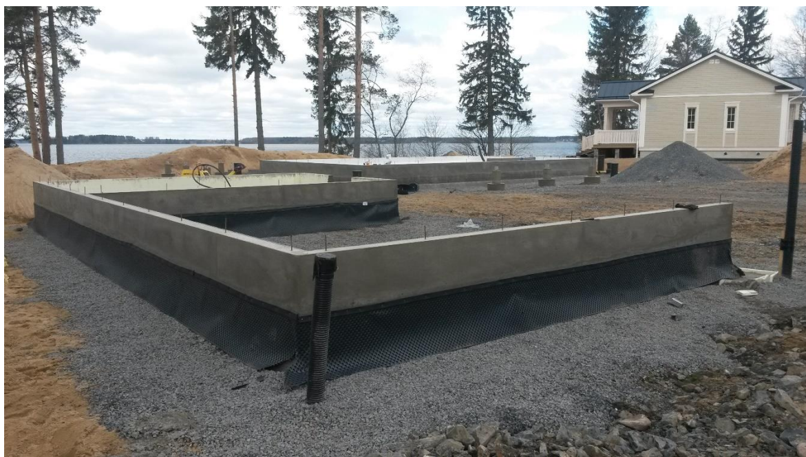
Kuva 1. Omakotitalon perustukset valmiina.
