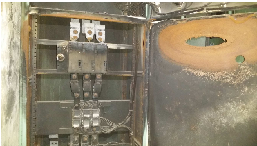
Kuva 8. Palanut keskus Aittaluodon voimalaitoksella.
