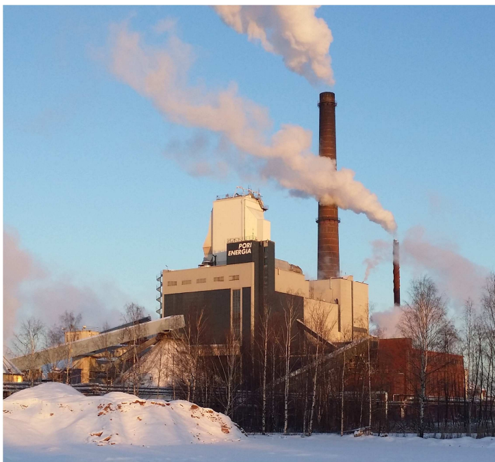
Kuva 2. Pori Energia Oy:n Aittaluodon voimalaitos
