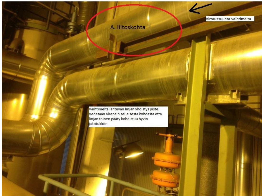
Kuva 13. Kohta A. lämmönsiirtimeltä tulevan putken ensimmäinen liitoskohta.
