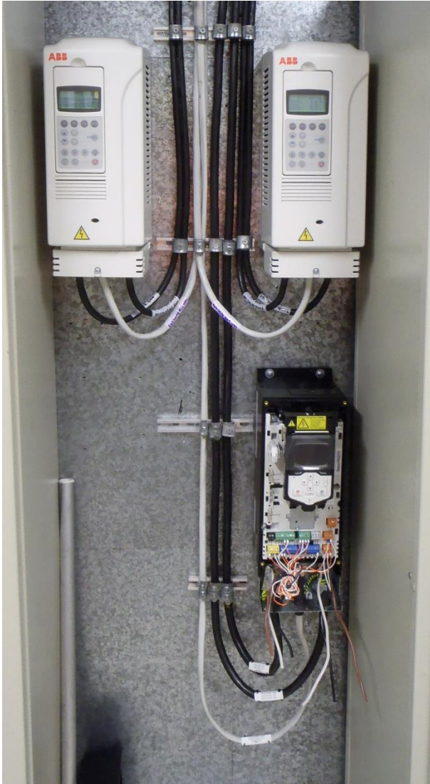
KUVA 17. Siirtoruuvikuljettimen taajuusmuuttaja asennusvaiheessa
