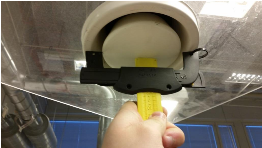
KUVA 12. KSO-venttiilin avauman mittaaminen
