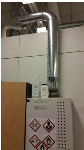
KUVA 7. Liuotinkaapin kohdepoisto
