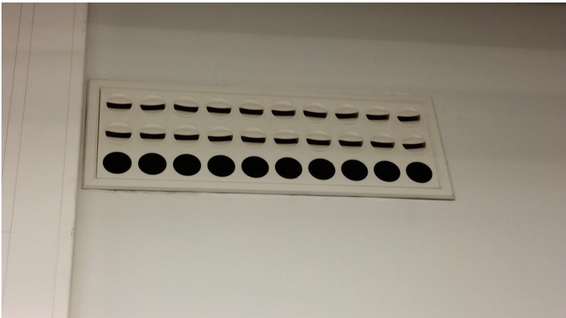
KUVA 17. Tuloilmalaite RP-laboratoriossa.
