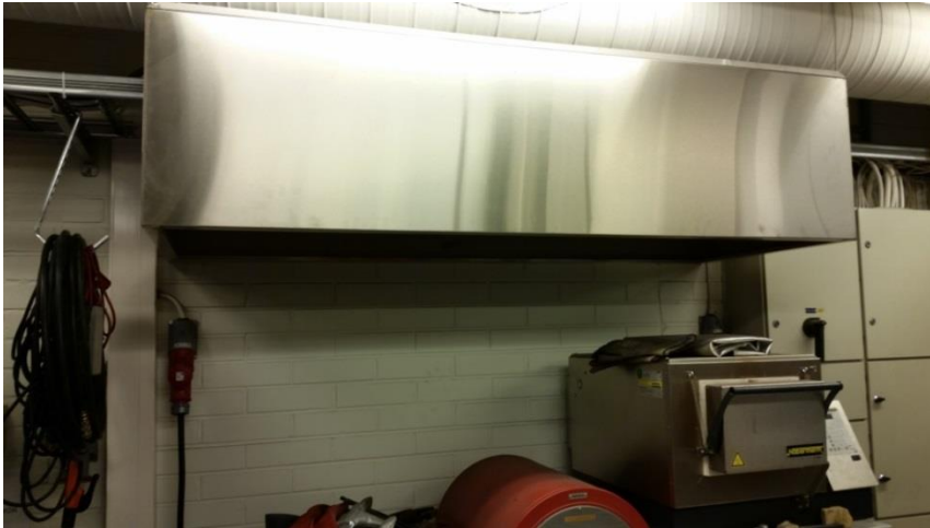
KUVA 6. Hitsauslaboratorion huuva
