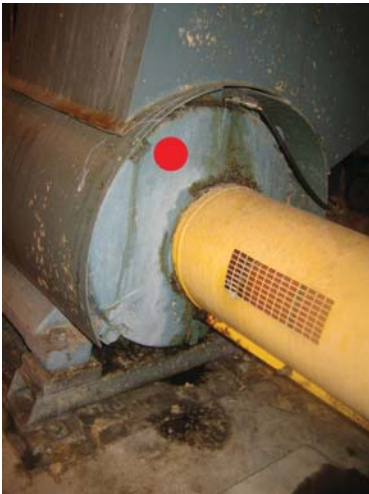
Kuva 4. Sähkömoottorin merkintä (Kuva: Teemu Ronkainen).
