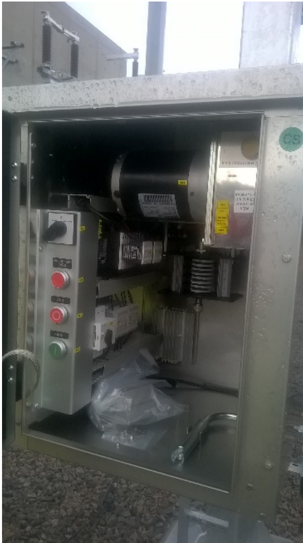
Kuva 11. Erottimen ohjaus voi tapahtua kuvan esimerkissä moottoriohjattuna etänä tai itse ohjauspisteessä ja kuvassa näkyvällä kammella käsivoimin.
