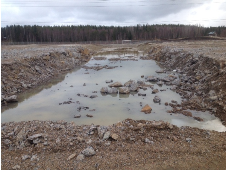
Kuva 23. Petäjävedellä portaalikanavannon lähtötaso. (Empower PN Oy)
