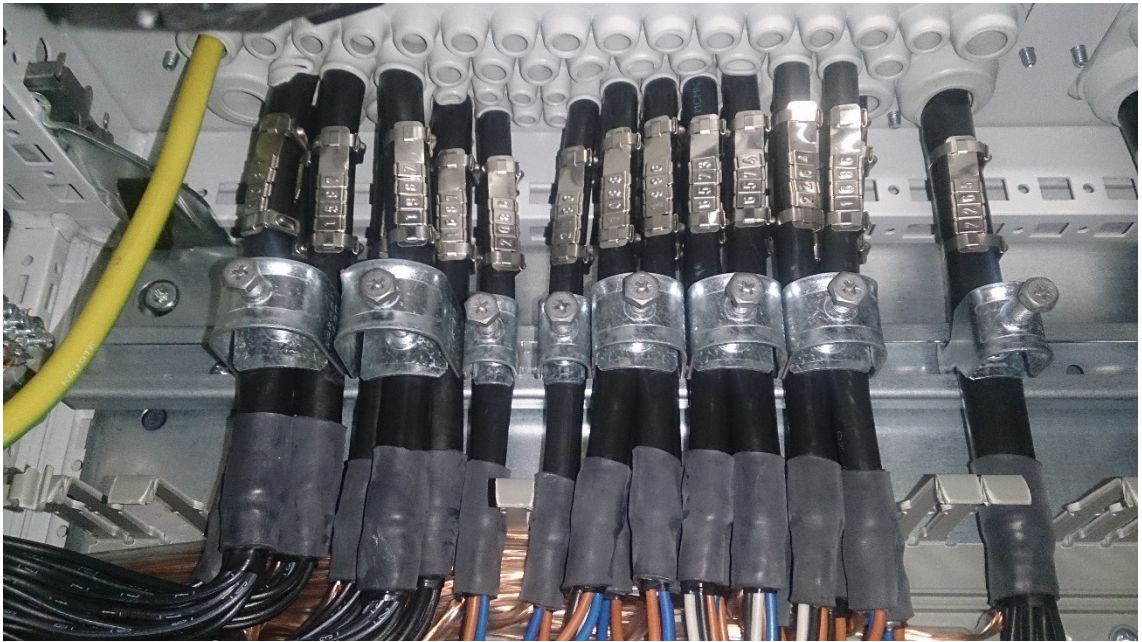
Kuva 29. Läpiviennit sisäkeskukseen.
