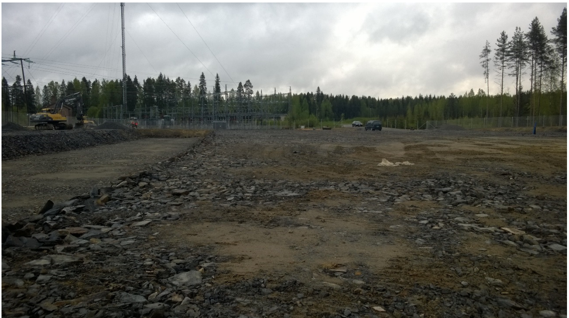
Kuva 24. Maanrakennuksen lähtötaso Mäntässä – vasemmalla portaalikanavanto. (Empower PN Oy)
