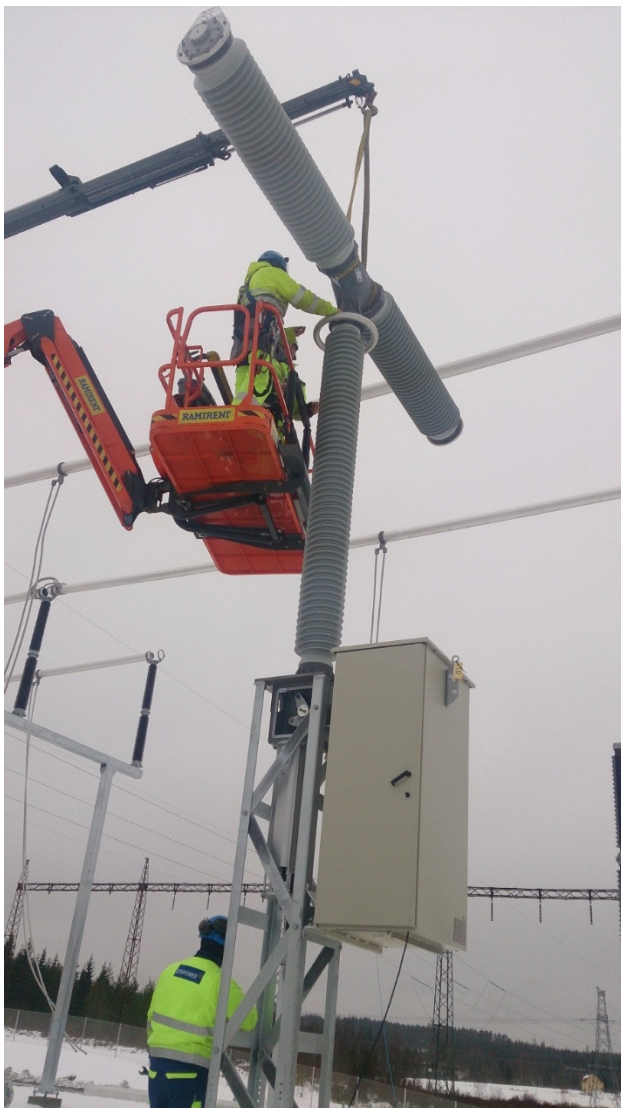
Kuva 34. Katkaisijayksikön ja koronarenkaan asentaminen.
