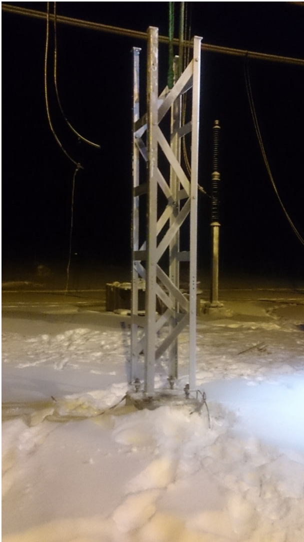
Kuva 31. Katkaisijan teräsrakenne odottamassa ohjainyksikön asentamista.
