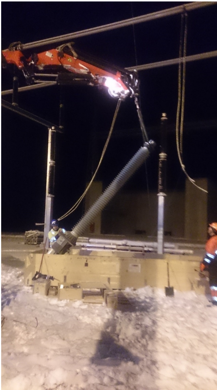
Kuva 32. Katkaisijakoneiston ja siihen kuuluvan eristimen nostaminen.
