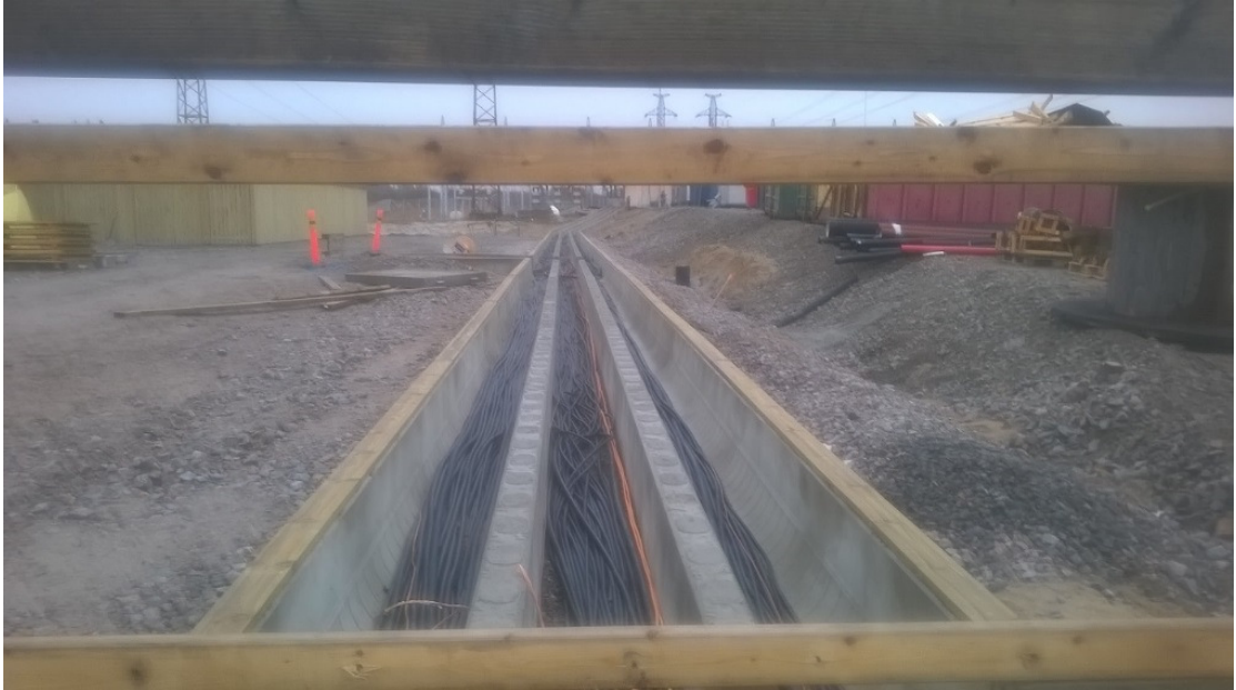
Kuva 15. Kaapelireitti kytkinkentältä asemalle
