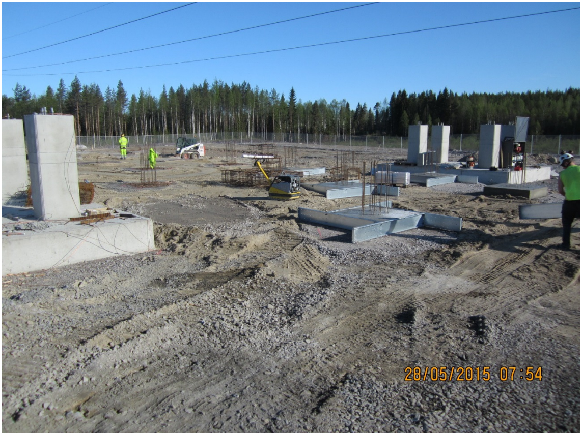
Kuva 27. Routarajan alle tulevia perustuksia. (Empower PN Oy)
