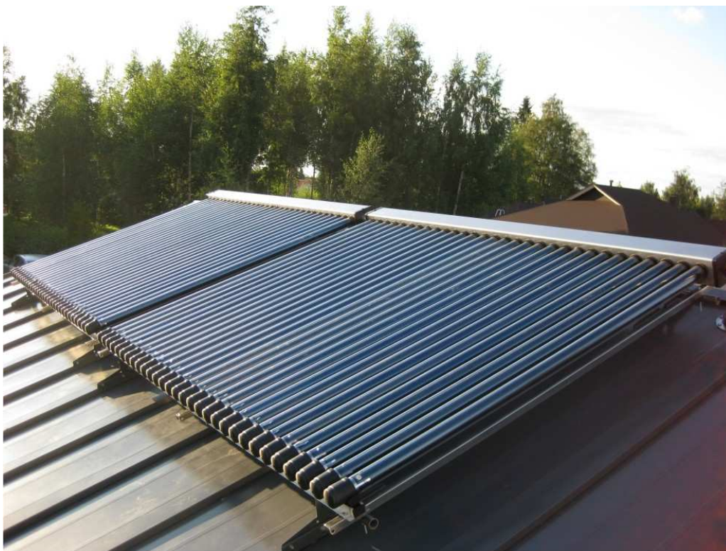
Kuva 6a: Tyhjiöputkikeräin pientalon konesaumapeltikatolla.(kylpyhuonemarket 2015)
