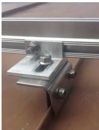
Kuva 38: Kuvassa konesauma, kiinnike, asennuslevy ja asennuskisko (aurinkovirta 2016)
