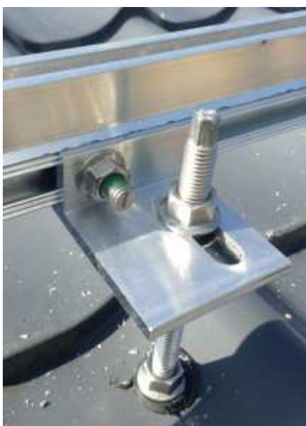
Kuva 35: Ankkuripultin katteen päällinen osuus. Kuvassa näkyy myös kumitiiviste, asennuslevy sekä asennuskisko. (aurinkovirta 2016)
