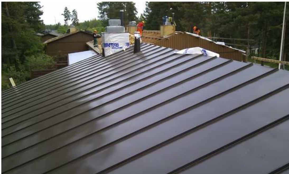
Kuva 11: Konesaumattu peltikatto (ulkoremontit 2015)
