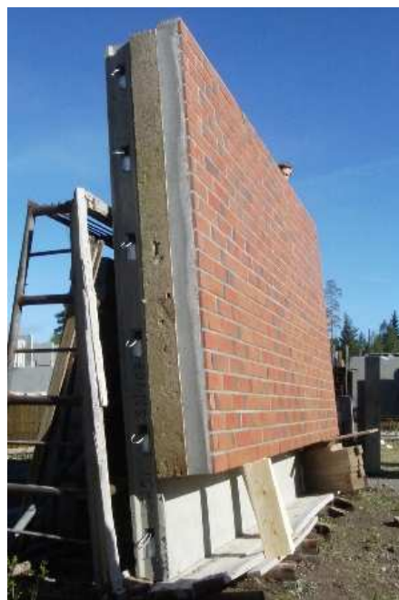
Kuva 15: Betonisandwich elementtirakenne (isover 2015)(rakennusperinto 2015)
