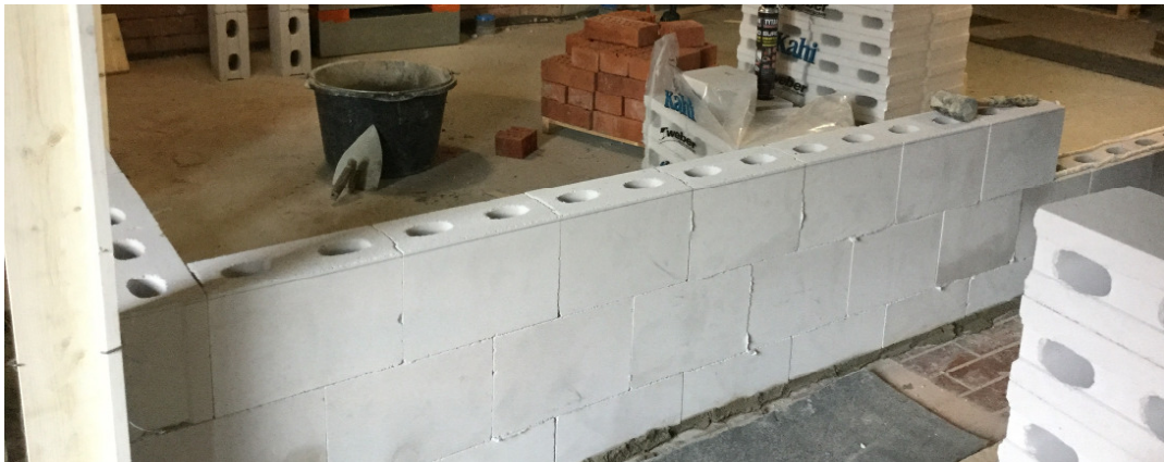
Kuva 25. Muuraustyöstä saadaan lähes pölytön käyttämällä laastin sijaan liimaa. (Kuva Anne Mutanen)
