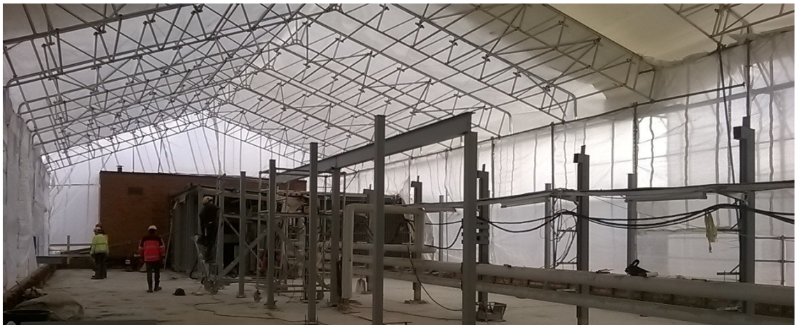
Kuvat 12-13. Metrian sääsuoja. Kuvat Anne Mutanen.
