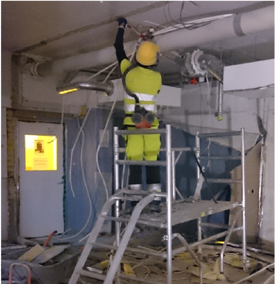
Kuva 11. Purkutyössä käytetään puhallinsuojainta. (Kuva Anne Mutanen)
