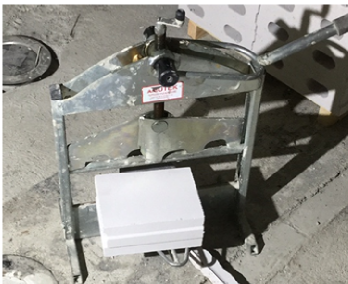
Kuva 26. Tiilet katkaistaan tiilileikkurilla. (Kuva Anne Mutanen)
