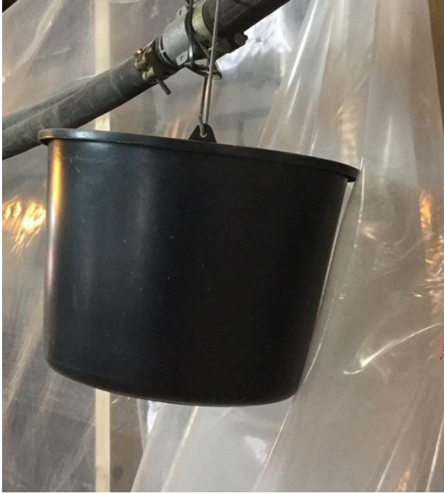
Kuvat 16. Vesiletkujen liitoksien mahdollisiin vuotoihin voidaan varautua valuma-astioiden avulla. (Kuva Anne Mutanen)
