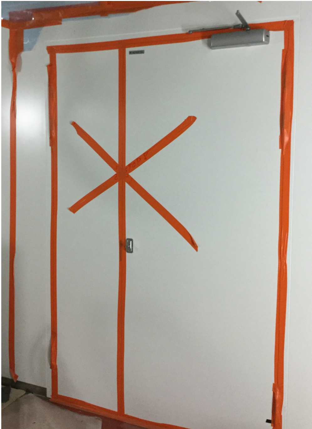
Kuva 2. Osastoitujen tilojen rajapinnat tiivistetään esimerkiksi teippaamalla. (Kuva Anne Mutanen)
