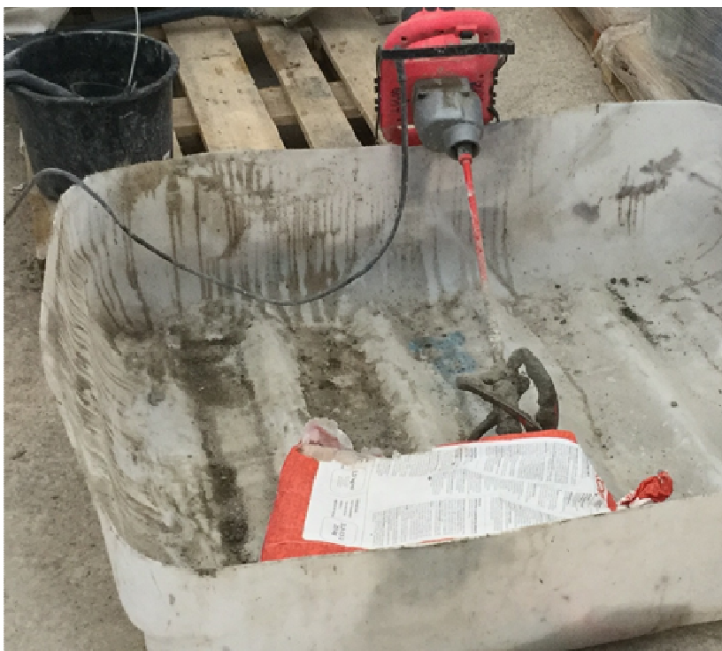
Kuva 24. Vispilää käytettäessä sekoitukset tehdään suojakaukalon päällä. (Kuva Anne Mutanen)
