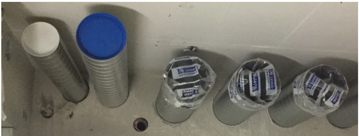
Kuva 19. Iv-kanavat suojataan pölyltä. (Kuva Anne Mutanen)
