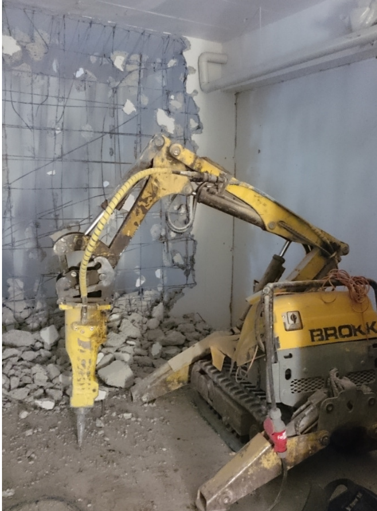
Kuva 21. Sähkökäyttöinen purkurobotti. (Kuva Anne Mutanen)
