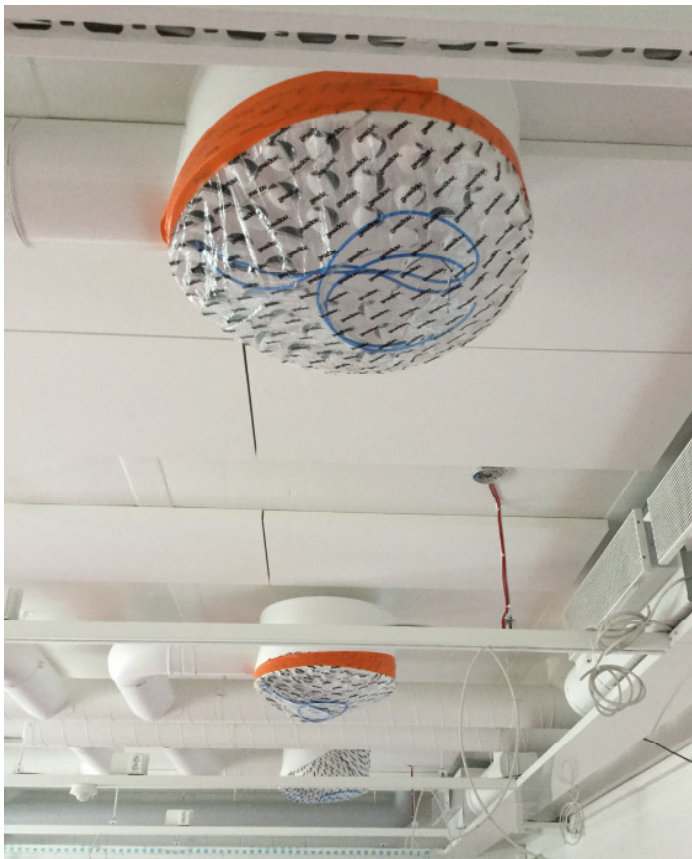
Kuva 8. Ilmanvaihdon päätelaitteet suojataan pölyltä. Suojat poistetaan vasta, kun tilat on siivottu. (Kuva Anne Mutanen)
