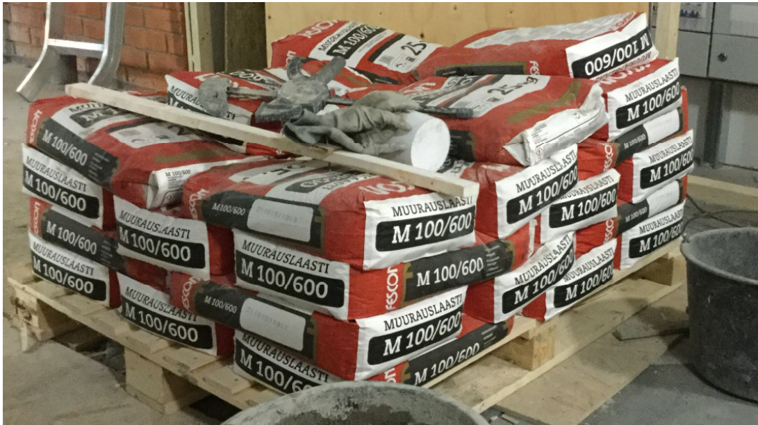
Kuva 15. Kosteudelle arat materiaalit varastoidaan sisätiloissa. (Kuva Anne Mutanen)
