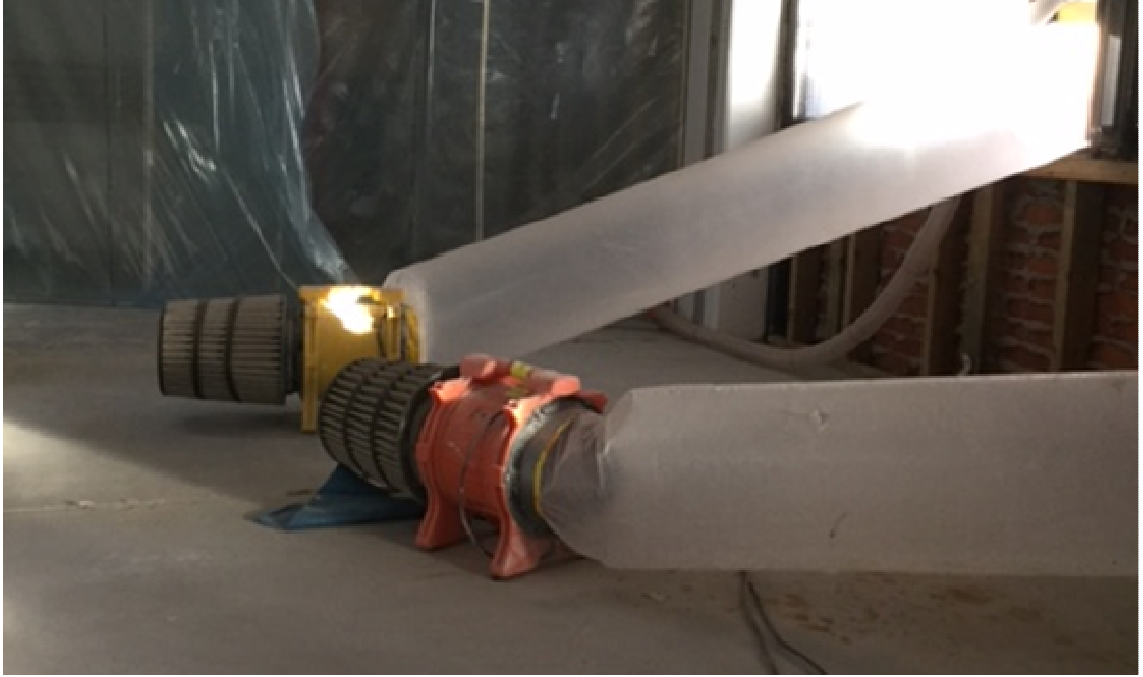
Kuva 4. Alipaineistajien avulla voidaan rajoittaa pölyn leviämistä ympäröiviin tiloihin. (Kuva Anne Mutanen)
