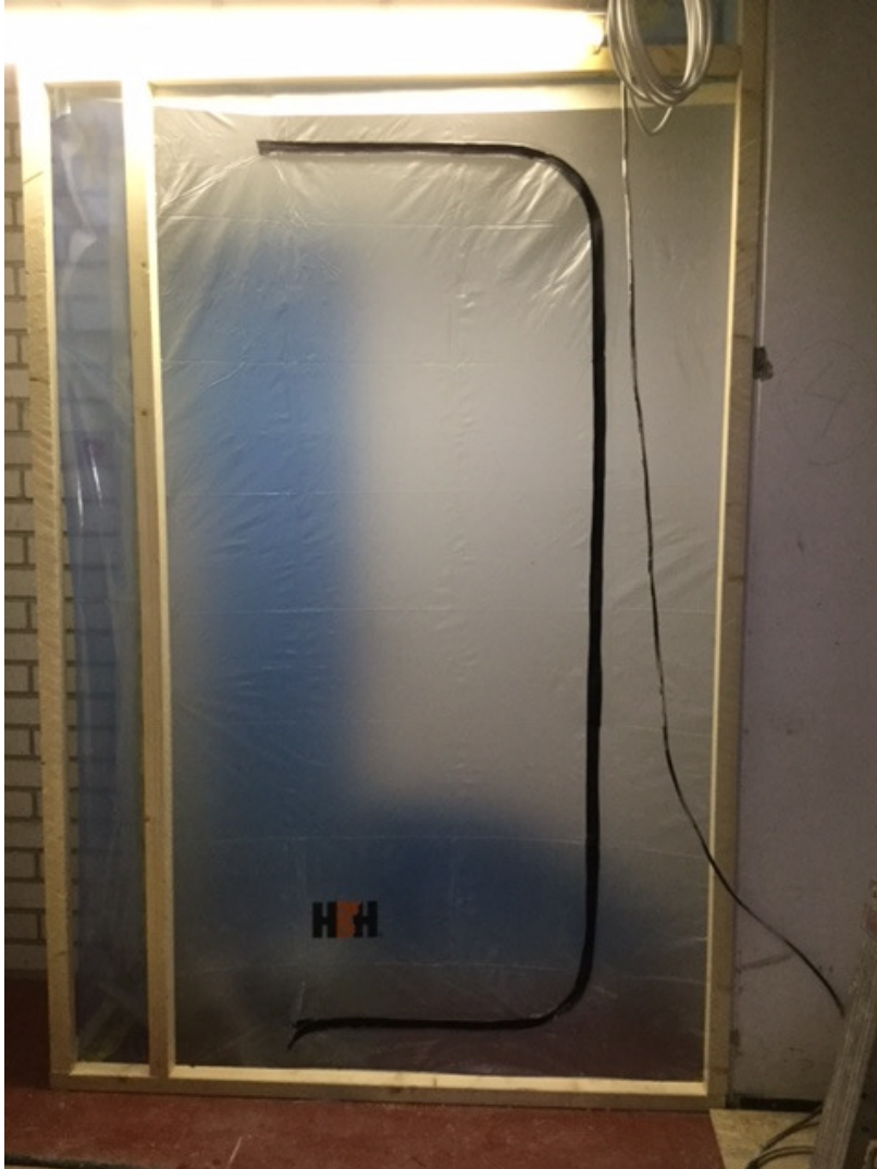
Kuva 3. Tarvittavat kulkuaukot väliaikaisiin suojaseiniin voidaan toteuttaa esimerkiksi vetoketjuovien avulla. (Kuva Anne Mutanen)
