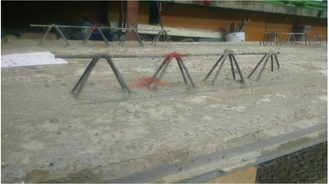
Kuvio 11. Kuorilaatan ansaat. (Alapuranen, J. 2016; Alapuranen, M. 2016.)
