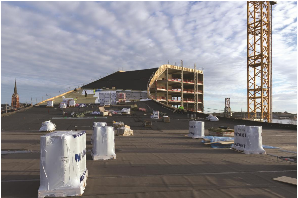
Kuvio 8. Kv Kajanin katto rakennusvaiheessa. (Alapuranen, J. 2016; Alapuranen, M. 2016.)
