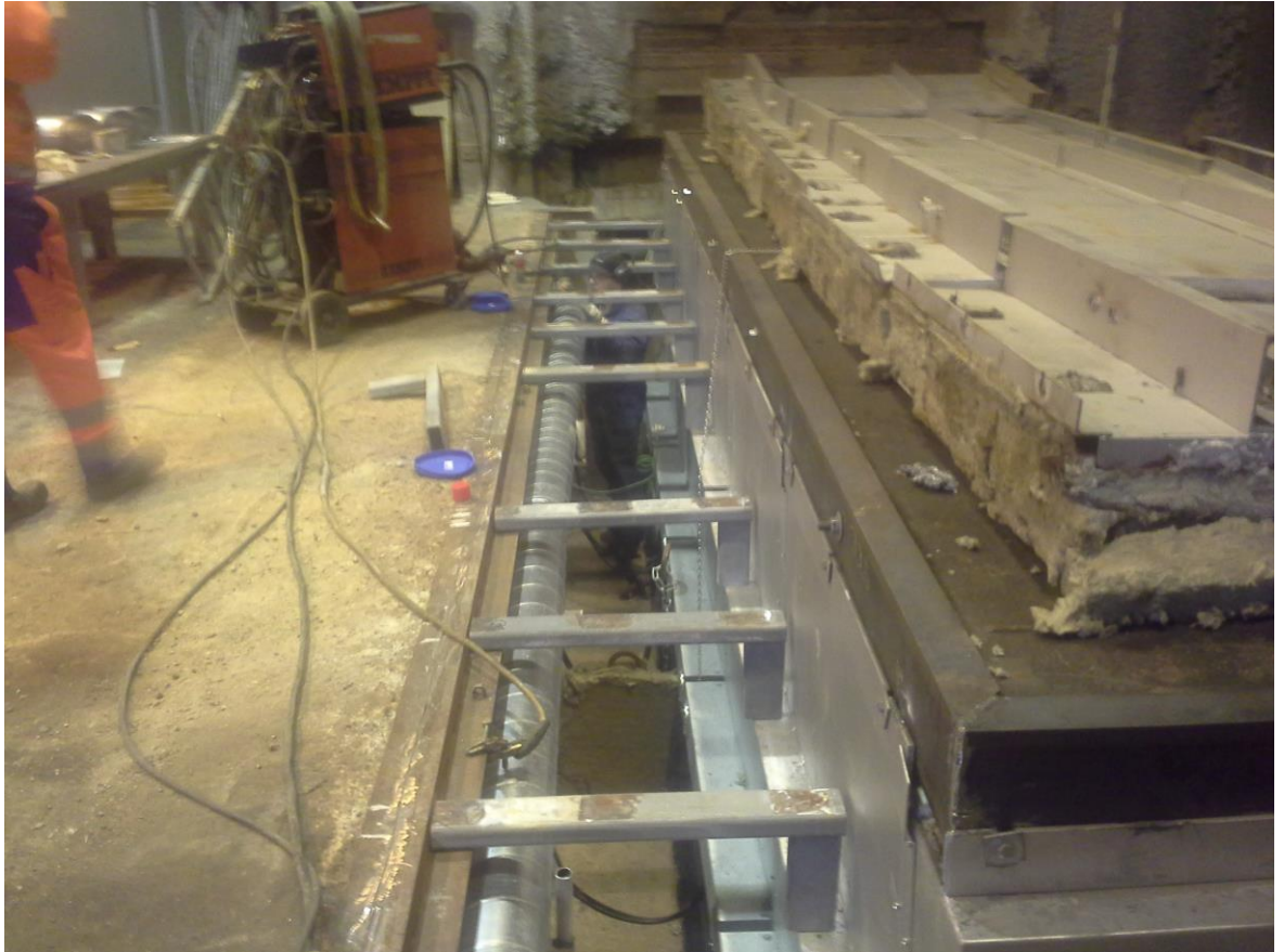
KUVIO 25. Sinkkipadan alueen lattian asennus.
