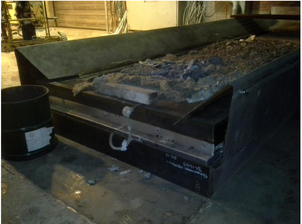
KUVIO 26. Padan sivureunapellit asennettuna paikoilleen.
