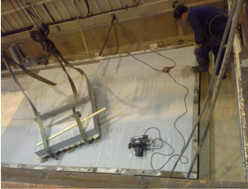
KUVIO 20. Pohjaeristelevyjien asettelu patamonttuun.
