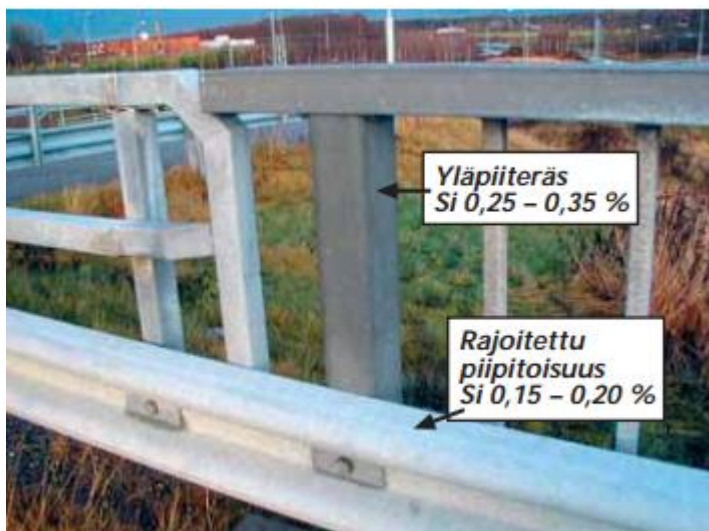
KUVIO 4. 15 vuotta käytössä olleet siltarakenteet. (Teräksen valintaohje kuumasinkittävään rakenteeseen)
