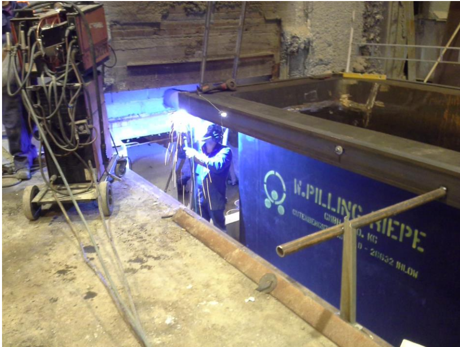
KUVIO 22. Vastuselementtien yläkiinnityspalkkien asennus sinkkipadan laippaan.
