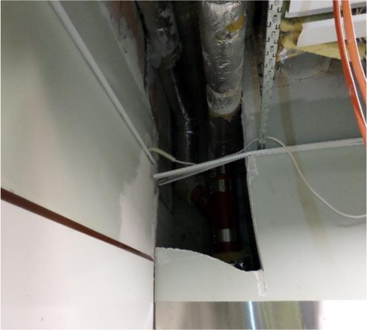
Kuva 19: Linjojen pohjaviemäriin liittymispaikka
