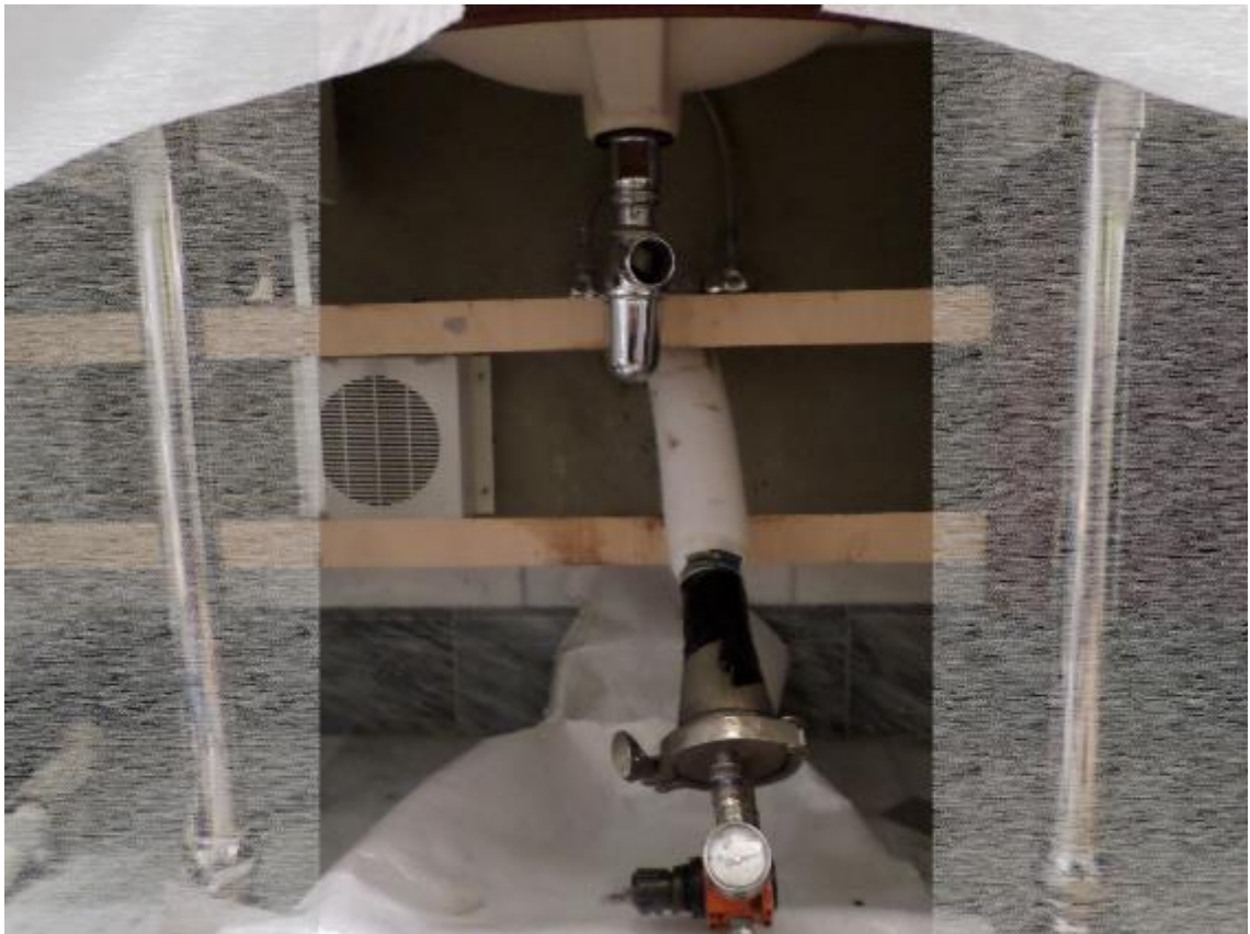
Kuva 13: Käsienpesualtaalta lähtevän viemäriin sukitustyö käynnissä
