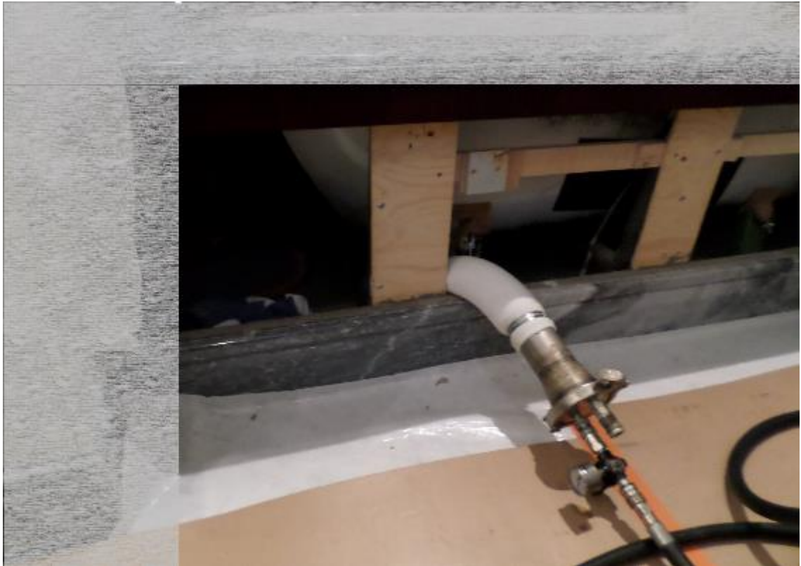
Kuva 14: Kylpyammeelta lähtevän viemärin sukitustyö käynnissä
