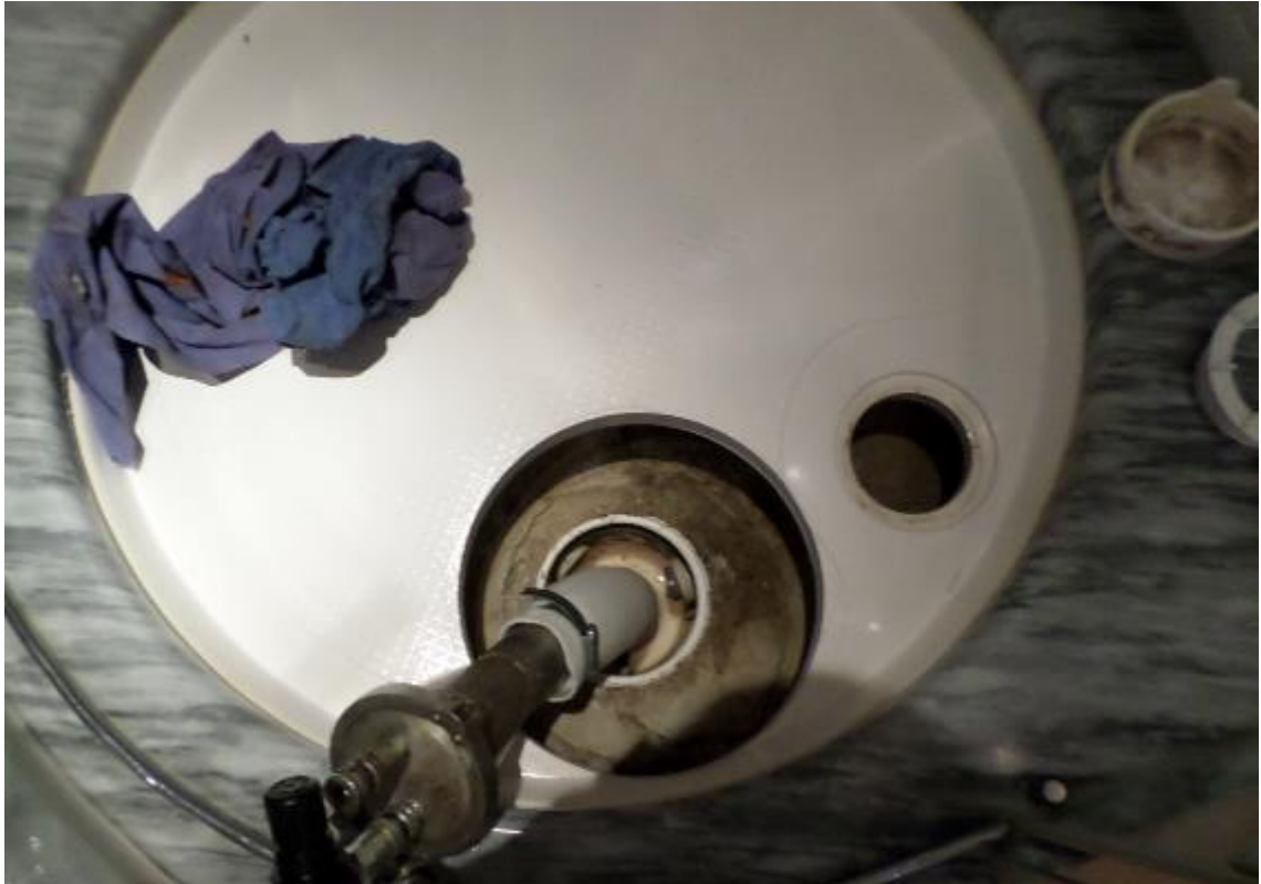
Kuva 15: Suihkualtaasen on porattu työskentelyä varten reikä, josta vedetään sukka
