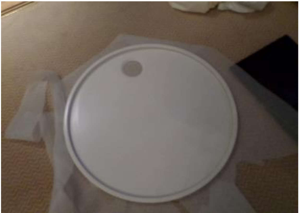
Kuva 16: Uusi allas, joka asennetaan vanhan päälle
