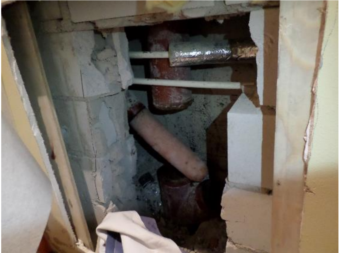
Kuva 11: Seinään on tehty reikä haarojen vaihtoa ja sukutusta varten
