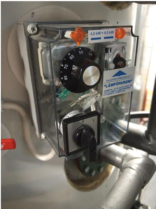
KUVA 11. Oilon VB9001 lämpöparoni
