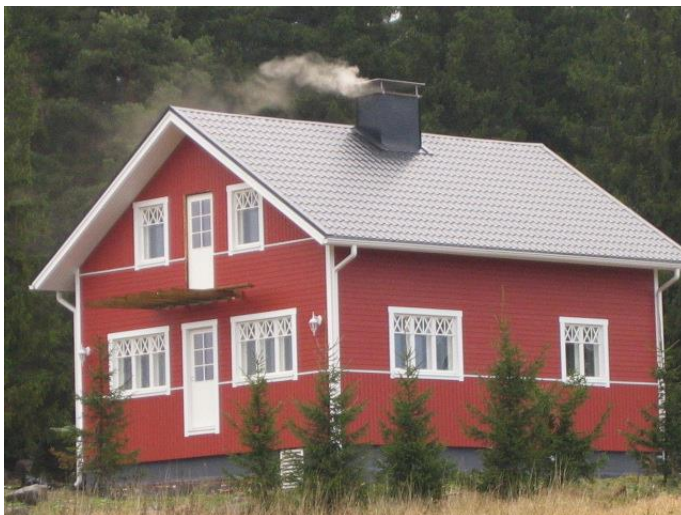
Kuva 11 Ovet, ikkunat ja vuorilaudoitus paikoillaan.
