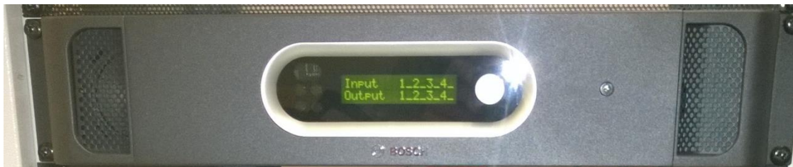
KUVA 21 Bosch Praesideo -järjestelmän verkko-ohjain (Pulkkinen 2016-02-11.)
