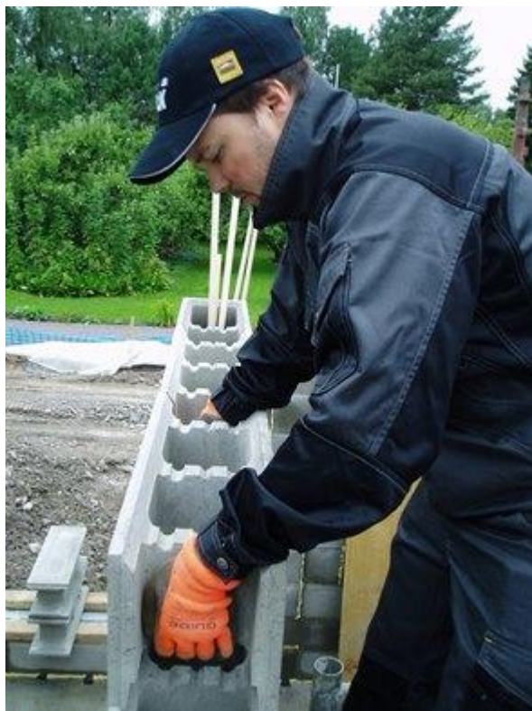
Kuva 3. Valuharkkojen ladontatyö (Lammin Betoni Oy 2016)
