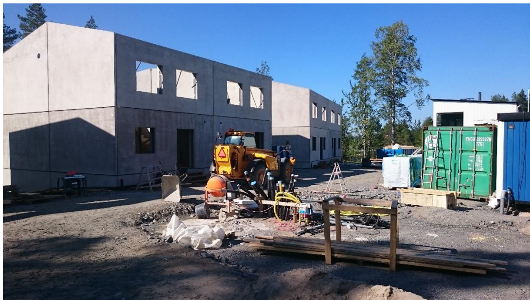
Kuva 14. Valmis sandwich-elementtiasennus Juha Semberg Oy:n paritalotyömaalla (Oksman 2015)
