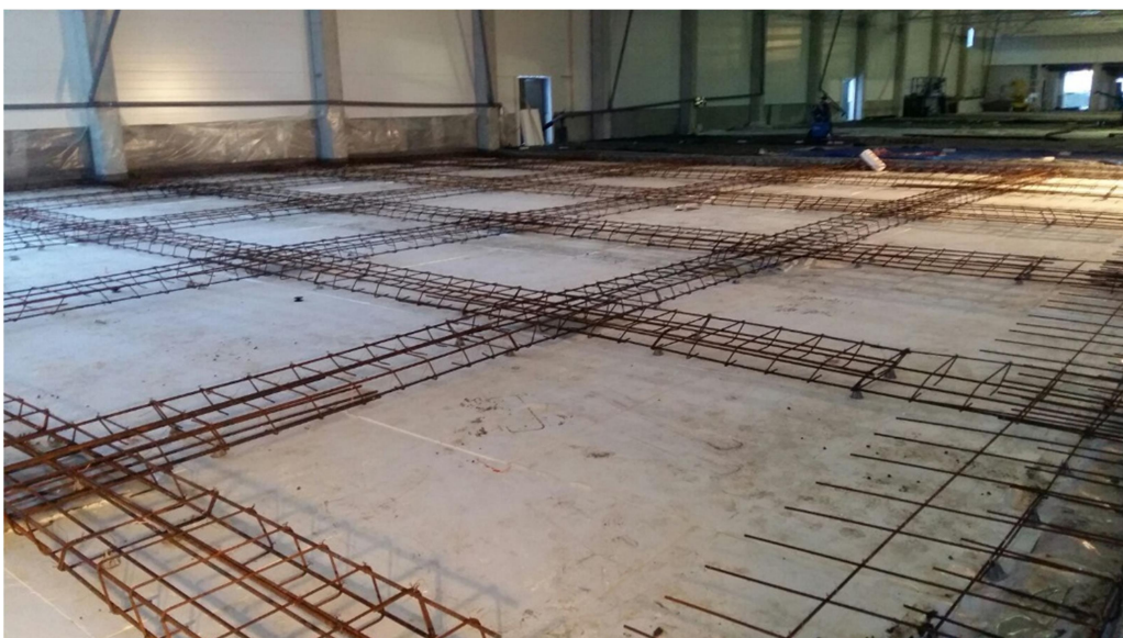
KUVA 11. Motonetin paalulinjaraudoitteet (Myllyneva 2015)
