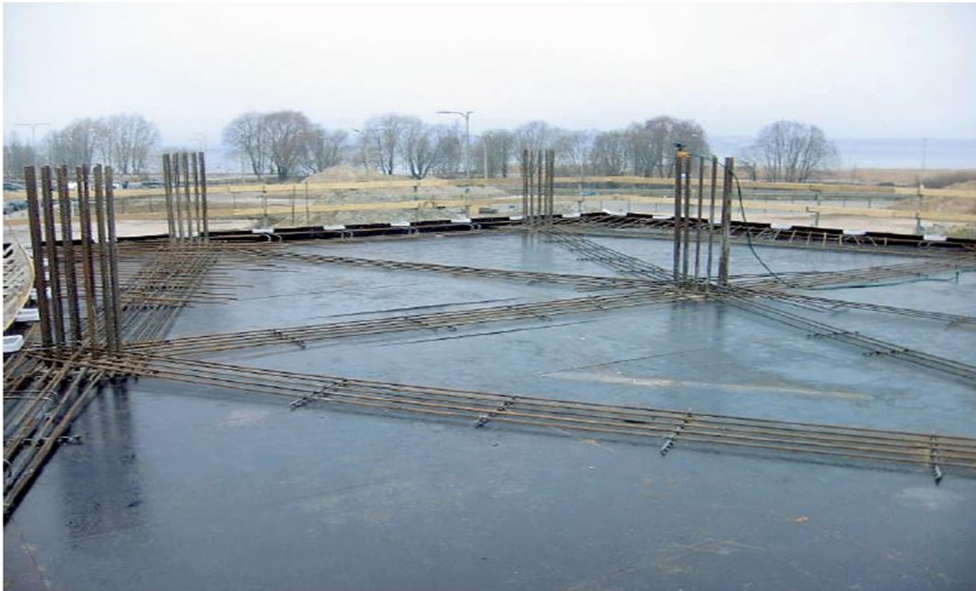
KUVA 9. APC-raudoitus pilarilinjoilla (Matsinen 2014)
