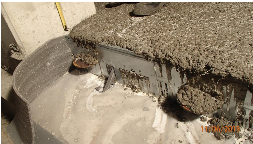
KUVA 12. Liikuntasaumarauta ja laatan irrottaminen muovilla
