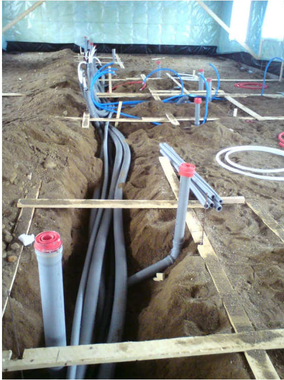
KUVA 5. Vesi- ja viemärijohdot
