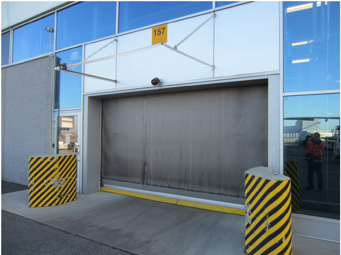
Kuva 24. Matkatavaravaunujen kulkuovi terminaalin länsiseinustalla. [27.]
