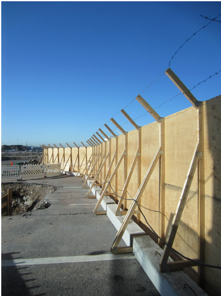
Kuva 15. Työmaa-alueen rajaamiseksi rakennettu aitaus. [18.]
