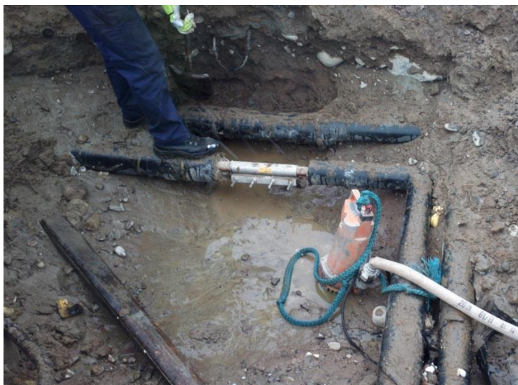
Kuva 5. Vuodon korjaus talvella väliaikaisella pannalla
