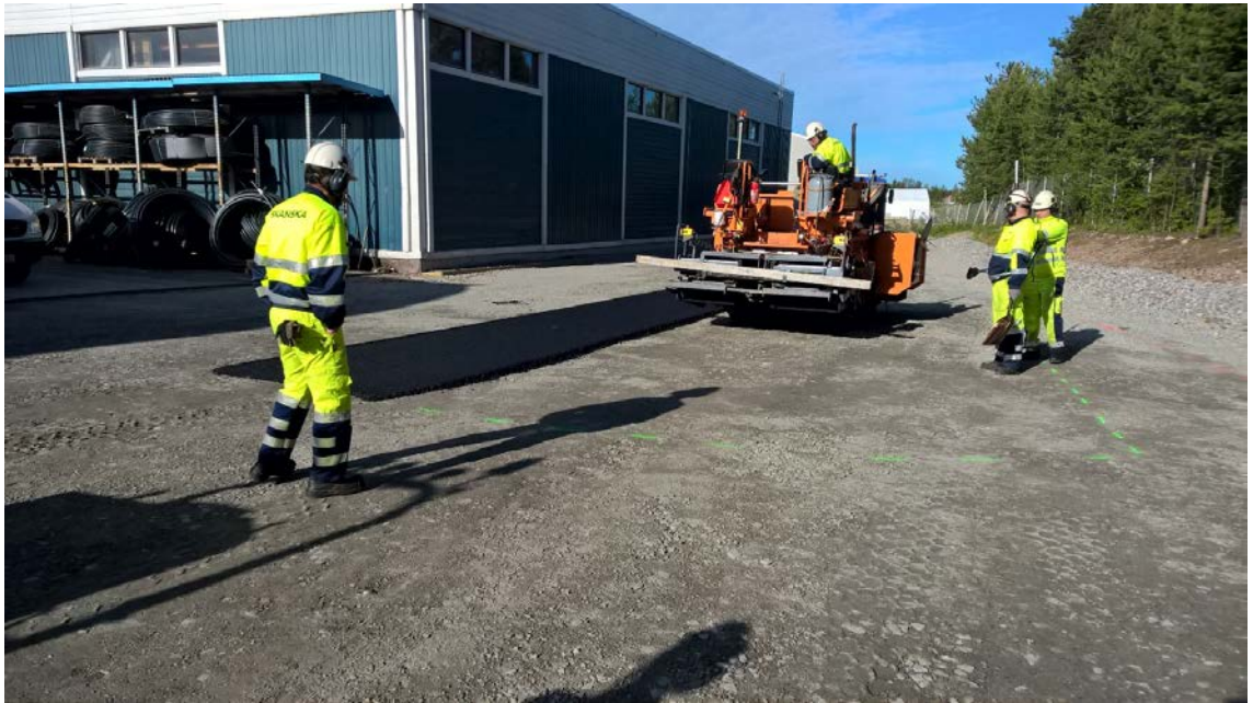
Kuvio 2. Pohjaan jäänyt kuoppa oiotaan asfaltilla ennen varsinaista päällystystä.
