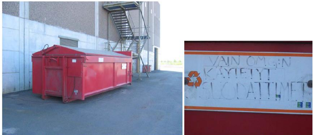
Pelkistämöllä sijaitsee kannellinen ilmastointisuodattimien keräyslava, jolla käytetyt suodattimet kuljetetaan nykyisin Ekokemille hävitettäväksi.
