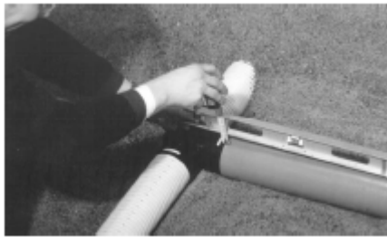
Kuva 20. Siirtokanavan kallistuksen tarkistus. [11, s. 13.]
