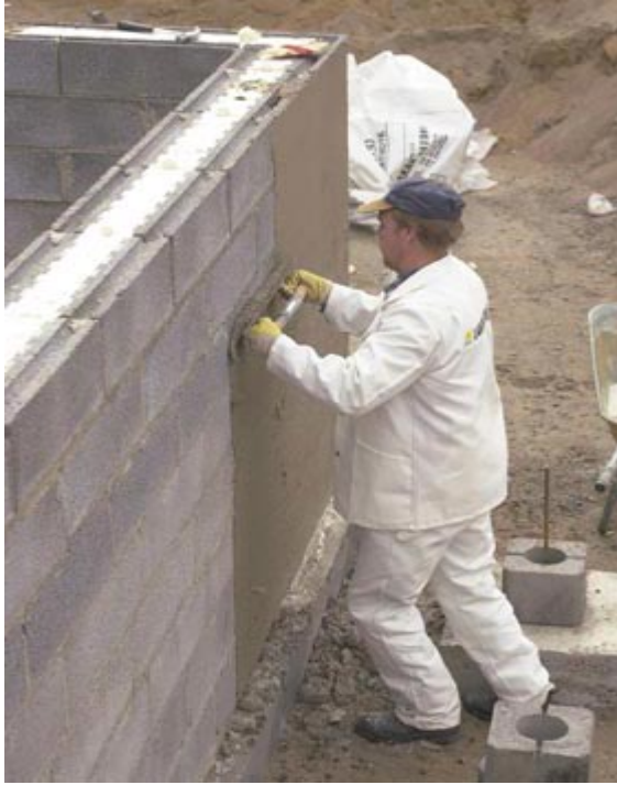
Kuva 11. Harkkoseinän ohutrappaus[13.]
