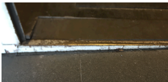
KUVA 11. Konserttitalon automaattioiven kynnyks on vasemmasta reunastaan 7 cm korkea ja oikeasta 1 cm.
