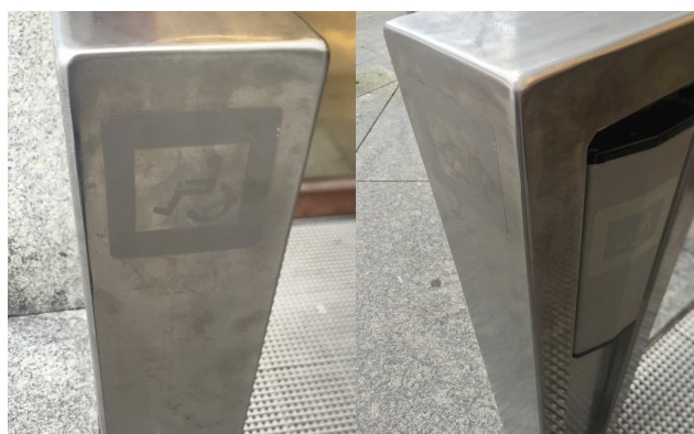
KUVA 2. Pääkirjaston pääsisäänkäynnin ovenavauspainiketolpan puutteelliset merkinnät. Merkintä ei juurikaan erotu taustastaan.
