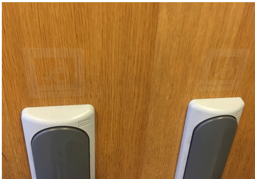
KUVA 3. Pääkirjaston pääsisäänkäynnin tuulikaapissa on erilliset ovenavausnapit sisä- ja ulko-ovelle. Näiden merkinnät eivät erotu juurikaan taustastaan.
