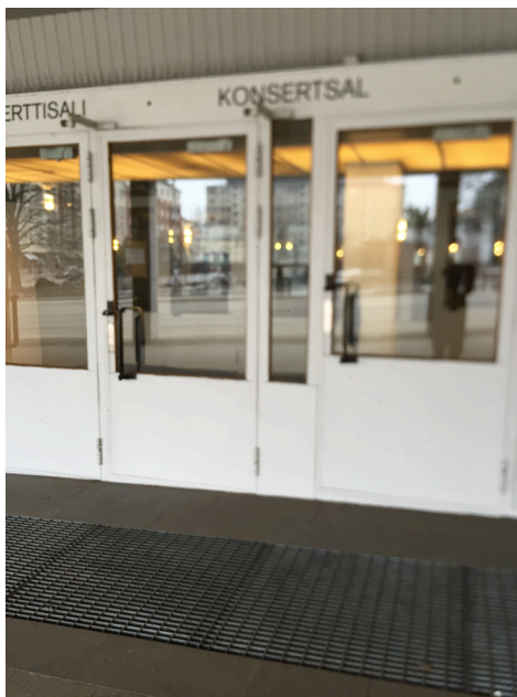
KUVA 9. Ovien kohdalla olevat opasteet eivät ole riittäviä, koska ne eivät näy tarpeeksi hyvin.
