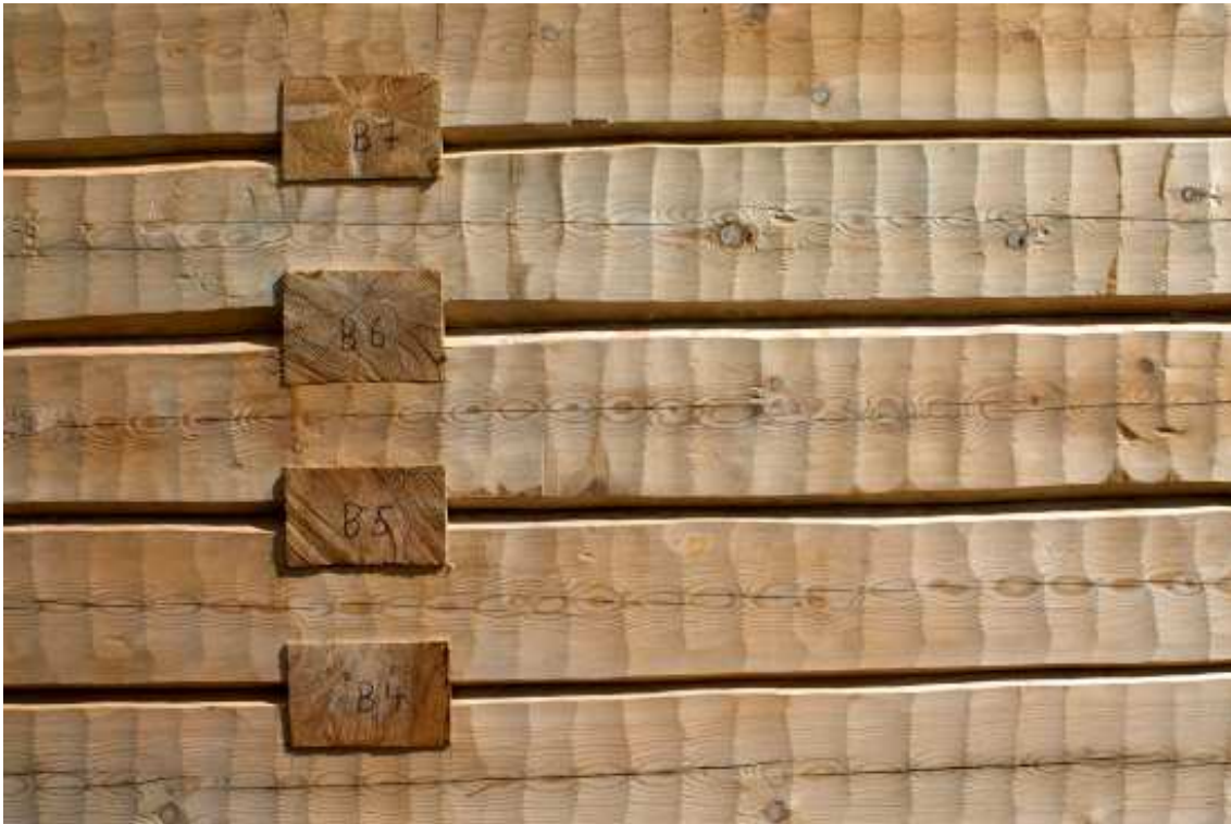
KUVA 2. Piilukirveellä veistetty pinta (Hirsisaunan pystytys)
