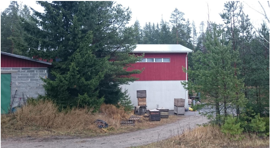
Kuva 5. Hallirakennus etelästä kuvattuna
