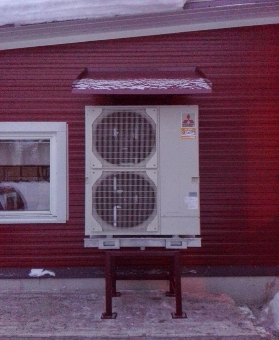
KUVIO 4. Ulkoyksikkö asennettuna maatumitelineelle
