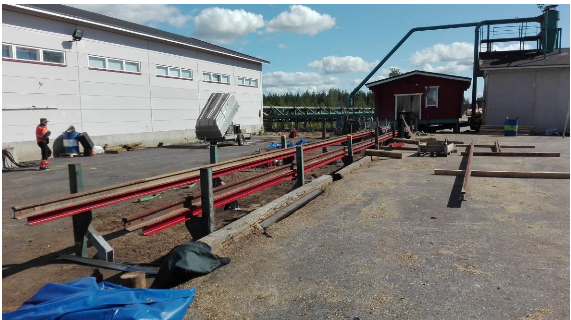
Kuvio 34. Poistoradan rakennustyöt käynnissä
