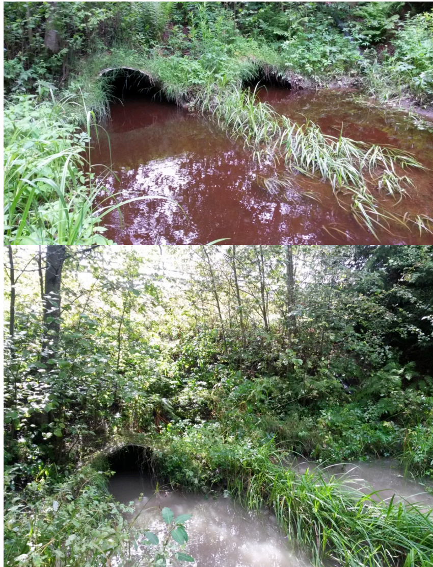
Kuva 22. Hirsimäen pisteen rumpujen alapää kesäkuussa ja elokuussa. Elokuussa vesi oli korkeammalla, koska oikeanpuoleiselle rannalla oleva hulevesiputki (5b) oli vedenpinnan tasolla.
