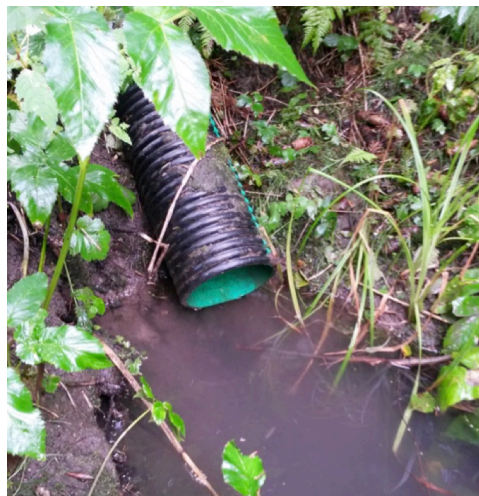
Kuva 23. Elokuussa Hirsimäessä oleva hulevesiputki (5b) oli vedenpinnan tasolla. Kesällä ämpärin sai hyvin putken alle.
