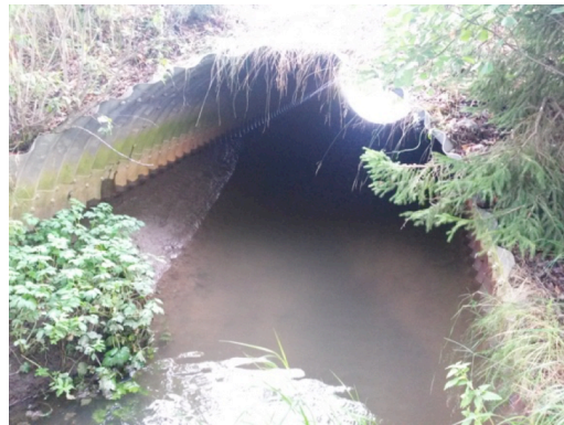
Kuva 19. Monissa rummuissa kiintoainesta oli kertynyt rumpujen pohjalle tai reunoille. Härkätien rummussa mutaa oli pohjalla noin 10 cm ja reunoillakin reilusti.
