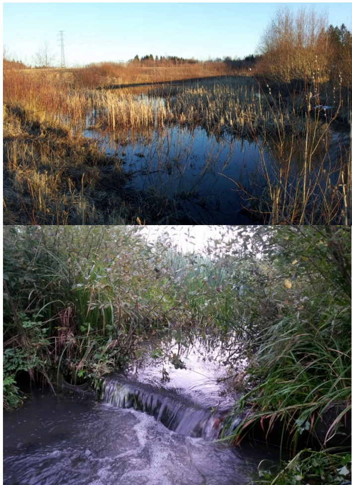
Kuva 27. Vuorentaan keskimäinen allas maaliskuussa. ja alakuvassa altaan pohjapato elokuussa, jolloin allas oli lähes vesikasvillisuuden peittämä.
