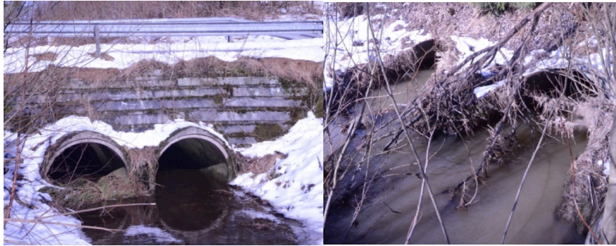
Kuva 20. Loimalahdentien (Kivisenojan) näytepisteellä oli maaliskuussa toinen putki tukossa. Tukoksia oli myös muualla (oik. Hirsimäen näytepiste) niin putkien päissä kuin joskus keskiosissakin, jolloin siivoustoimista huolimatta virtaamamittaus ei onnistunut.
